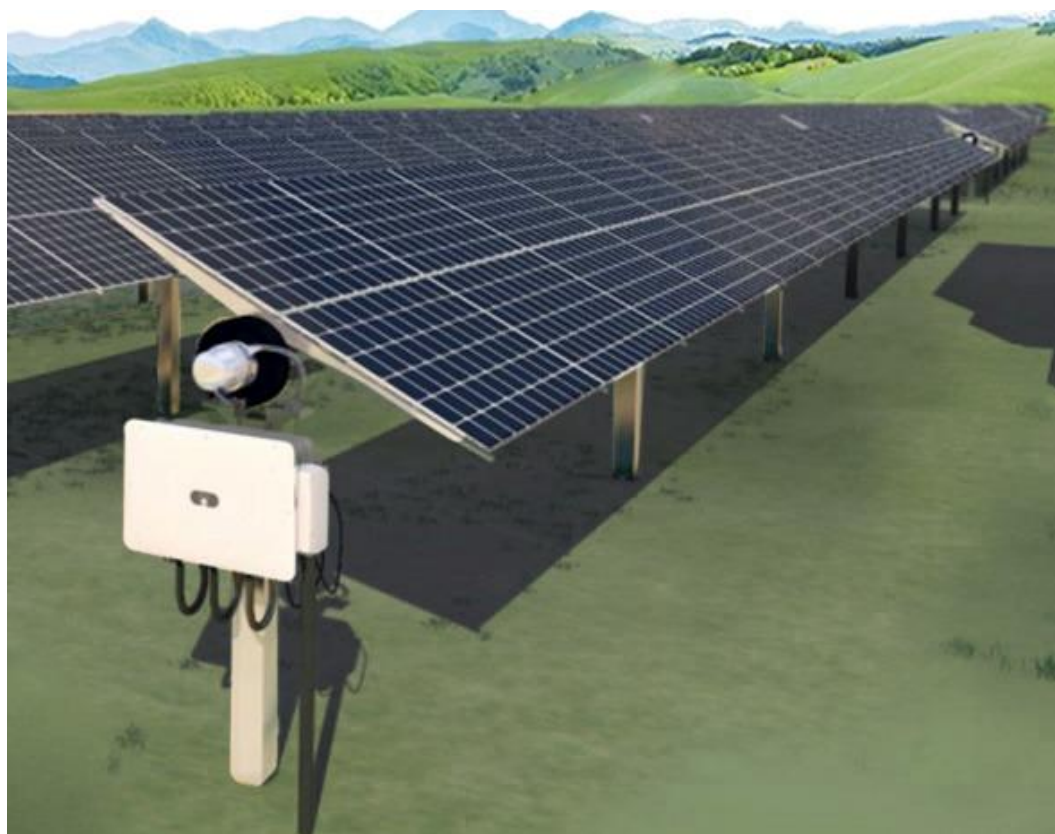
Figura 7-5 – Esempio di installazione gruppo di conversione CC/CA (String Inverters)
