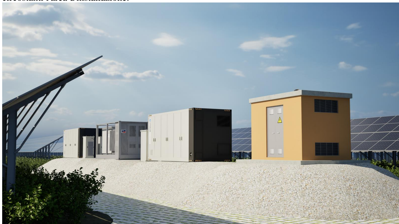
Figura 6-1: Rendering Cabinati Power Station, Container batterie e Cabina ausiliaria
