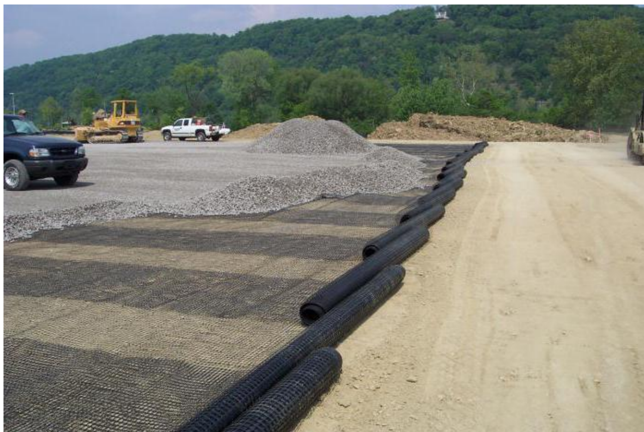
Figura 32 _immagine esemplificativa (fonte google) dell'applicazione di geogriglia di rinforzo alla base del rilevato
