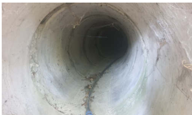
Tratto 6: Tratto di ca. 24 m di n. 2 DN1000 CLS di scarico dal lago a monte del Tratto 5, a tergo di sbarramento in terra esistente (lesioni e giunti disassati)
