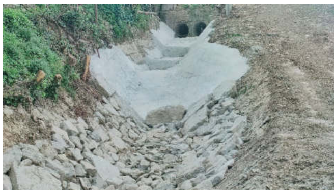
Tratto 5: Gabbionate di ca. 15 m (corpo di scarico lago) a monte del Tratto 4 e a valle del Tratto 6, con rivestimento in c.a. ripristinato mediante preventiva bonifica superficiale (picchiettatura) delle parti ammalorate/danneggiate e successiva ricostruzione delle parti demolite, con foderi di 5-10 cm di malta cementizia
