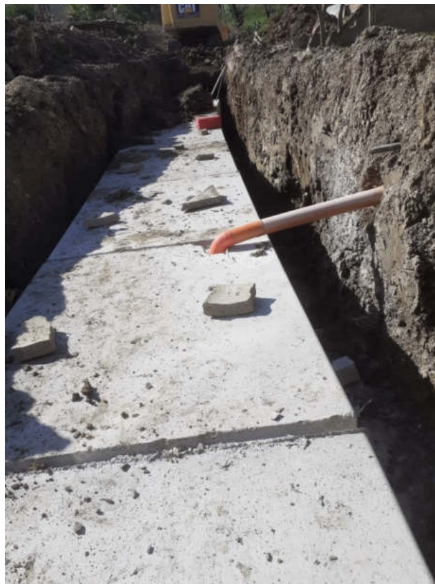
Tratto 2: Lavori in corso per la realizzazione di nuova tombinatura del rio con scatolari prefabbricati in cls 160xh80 cm, dal Punto 1 verso monte per ca. 35 m
