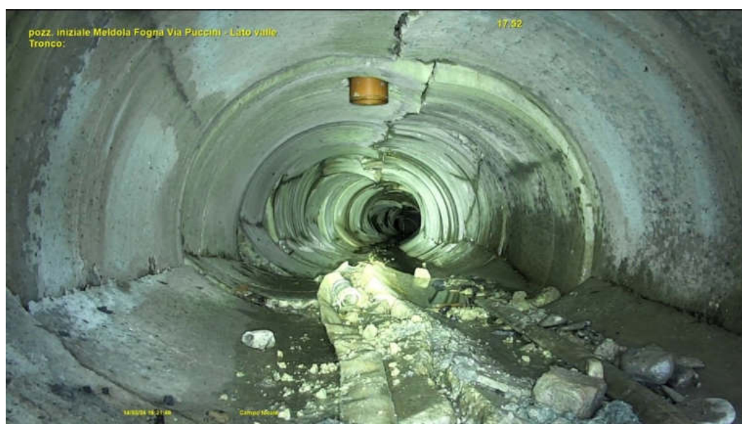
Tratto iniziale del DN900 a valle del punto 1. del presente intervento (dissesti importanti e diffusi del condotto)”
