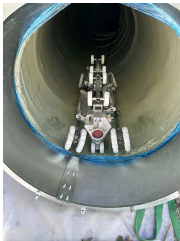
Tratto 6: Tratto di ca. 24 m di n. 2 DN1000 CLS di scarico dal lago a monte del Tratto 5, oggetto di risanamento c.d. "relining cipp UV", con liner in composito PRFV e resina poliestere fotosensibile
