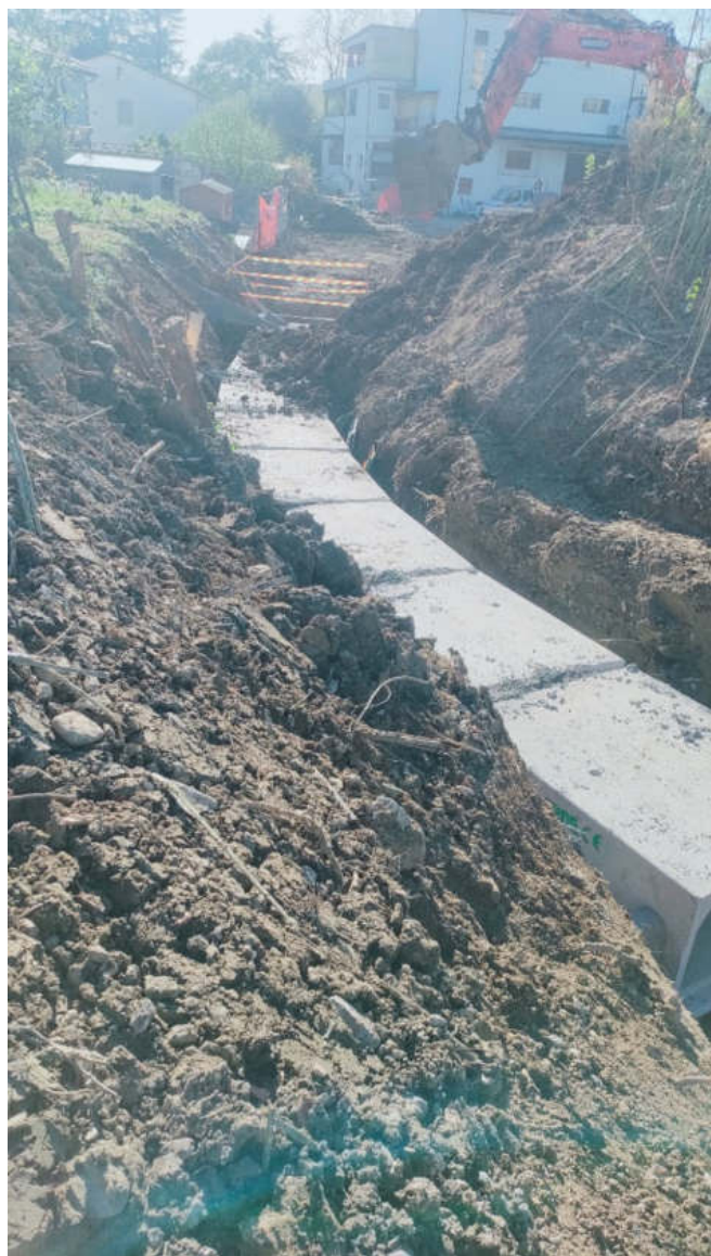
Tratto 3: Lavori in corso per la realizzazione di nuova tombinatura del rio con scatolari prefabbricati in cls 160xh80 cm, a monte del Tratto 2 per ca. 21 m
