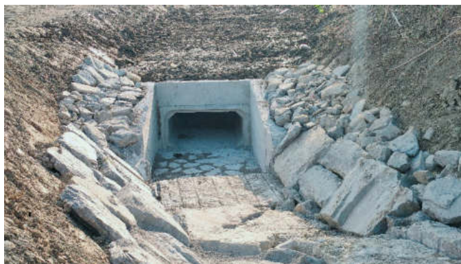
Tratto 4: Vista da monte dei lavori in corso per la realizzazione del manufatto in c.c.a. di imbocco del nuovo scatolare in cls 160x80 cm
