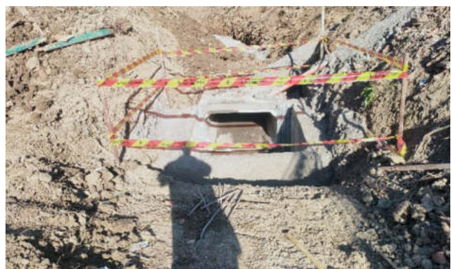
Tratto 3: Lavori in corso per la realizzazione di nuova cameretta "di salto di fondo" in c.c.a. in opera (soletta prefabbricata), di raccordo con il Tratto 2 vallivo
