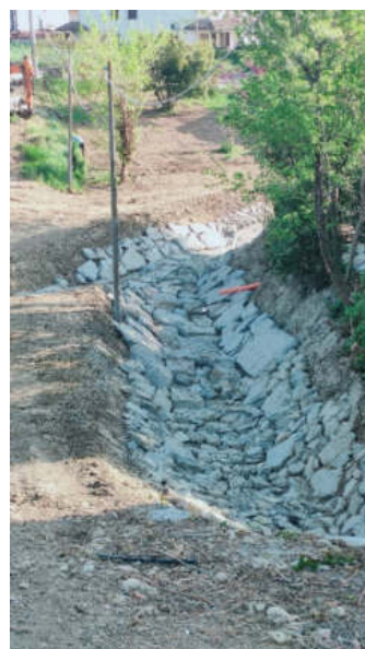
Tratto 4: Vista verso valle dei lavori eseguiti per le nuove difese in massi dell'intero tratto a cielo aperto del rio, con pietrame di arenaria, elementi 51-3000 kg, per ca. 40 m a monte del Tratto 3
