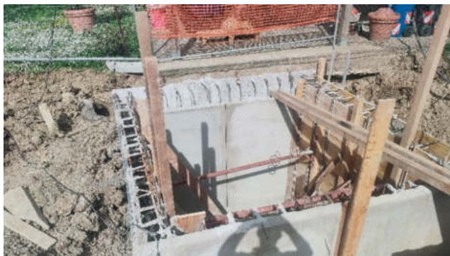
Punto 1: Lavori in corso per la realizzazione in opera di pozzetto/cameretta terminale in c.c.a.
