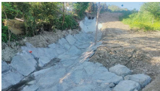
Tratto 4: Vista verso monte dei lavori eseguiti per le nuove difese in massi dell'intero tratto a cielo aperto del rio, con pietrame di arenaria, elementi 51-3000 kg, per ca. 40 m a monte del Tratto 3
