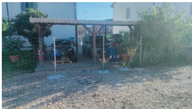
Punto 1: Lavori finiti di realizzazione in opera di pozzetto/cameretta terminale in c.c.a., con ripristino di piazzale privato (è evidente la posizione del chiusino d'ispezione, a 4 coperchi triangolari)
