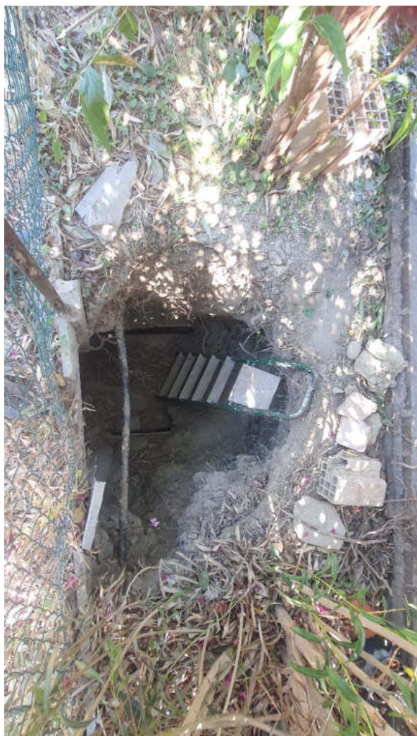
Punto 1: Crollo del tombinamento DN900 CLS del rio e del sovrastante terreno (giardino privato)
