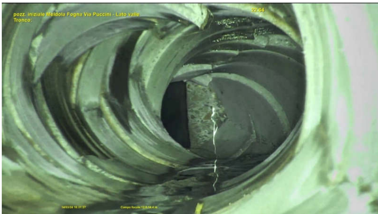
Figura 23: Stato di conservazione della condotta in cls DN 900 oggetto di relining
