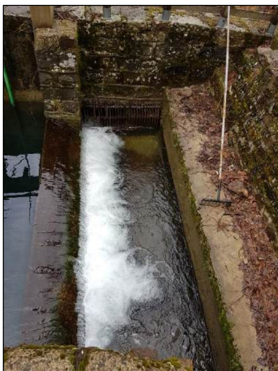
Figura 3.3.12: presa Rio della Costa – punto di presa con griglia (foto a sx) e seconda vasca di decantazione (foto a dx)
