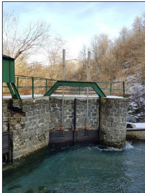
Figura 3.2.7: presa Parma di Badignana - opere di presa in sinistra idraulica (foto a sx); sempre in sinistra idraulica paratoie sghiaiatrici manuali (foto a dx)
