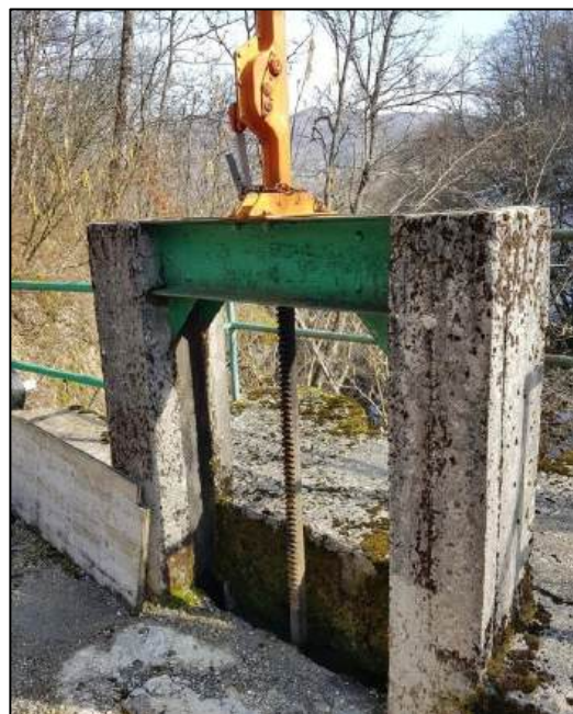
Figura 3.3.15: presa Roncovecchio – sfioratore sul ponte canale (foto a sx) e paratoia di scarico canale (foto a dx)
