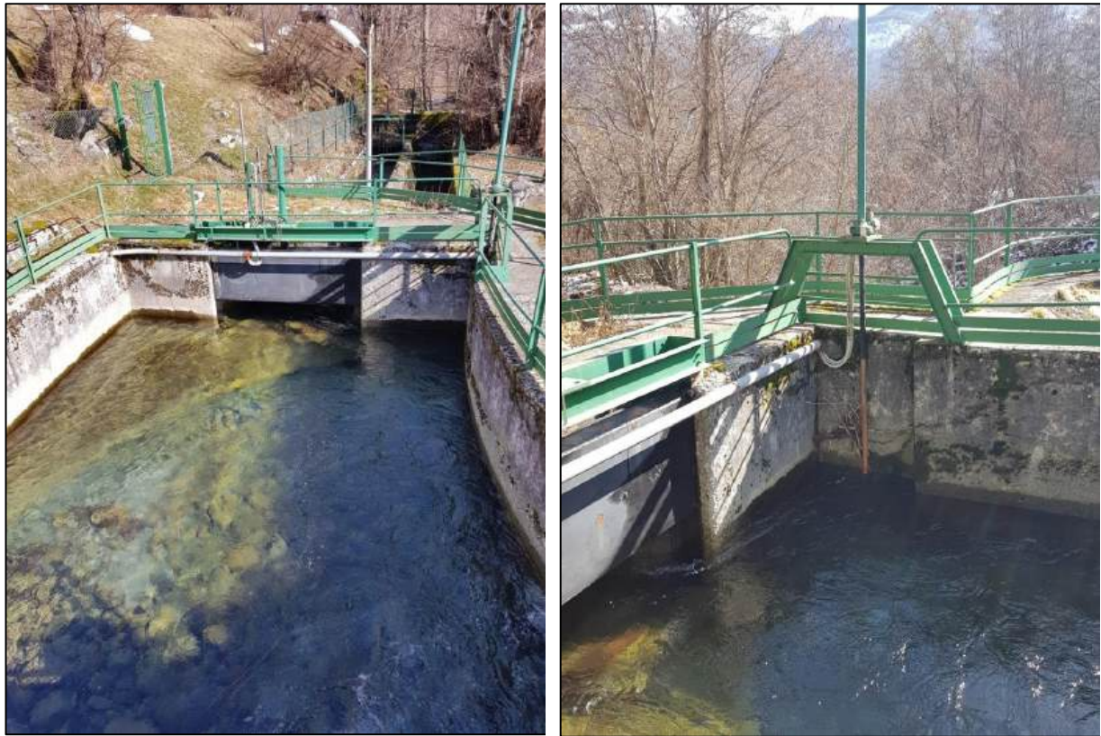
Figura 3.2.15: presa Parma del Lago Santo – vasca di decantazione con paratoia piana dissabbiatrice
