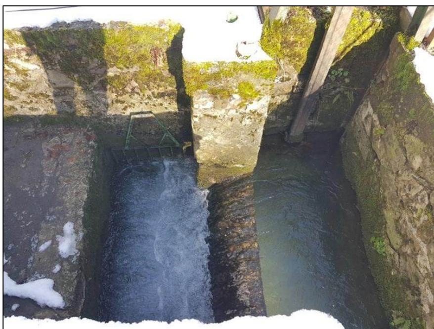
Figura 3.2.5: Rio della Sesta - punto di derivazione con vasca di decantazione.
