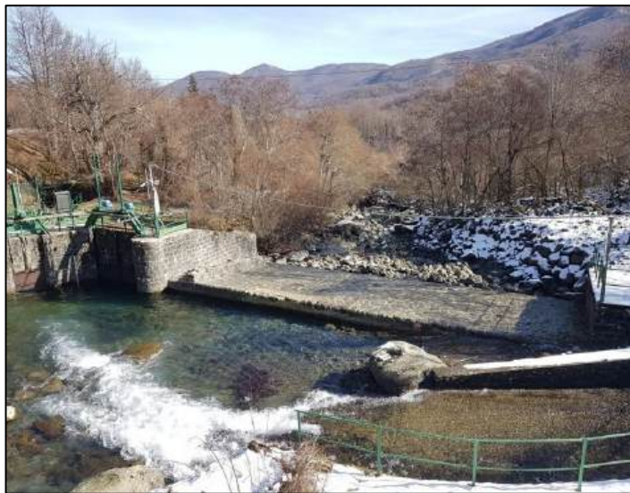
Figura 3.2.13: presa Parma del Lago Santo – sfioratore presa e arrivo canale da presa Parma di Francia
