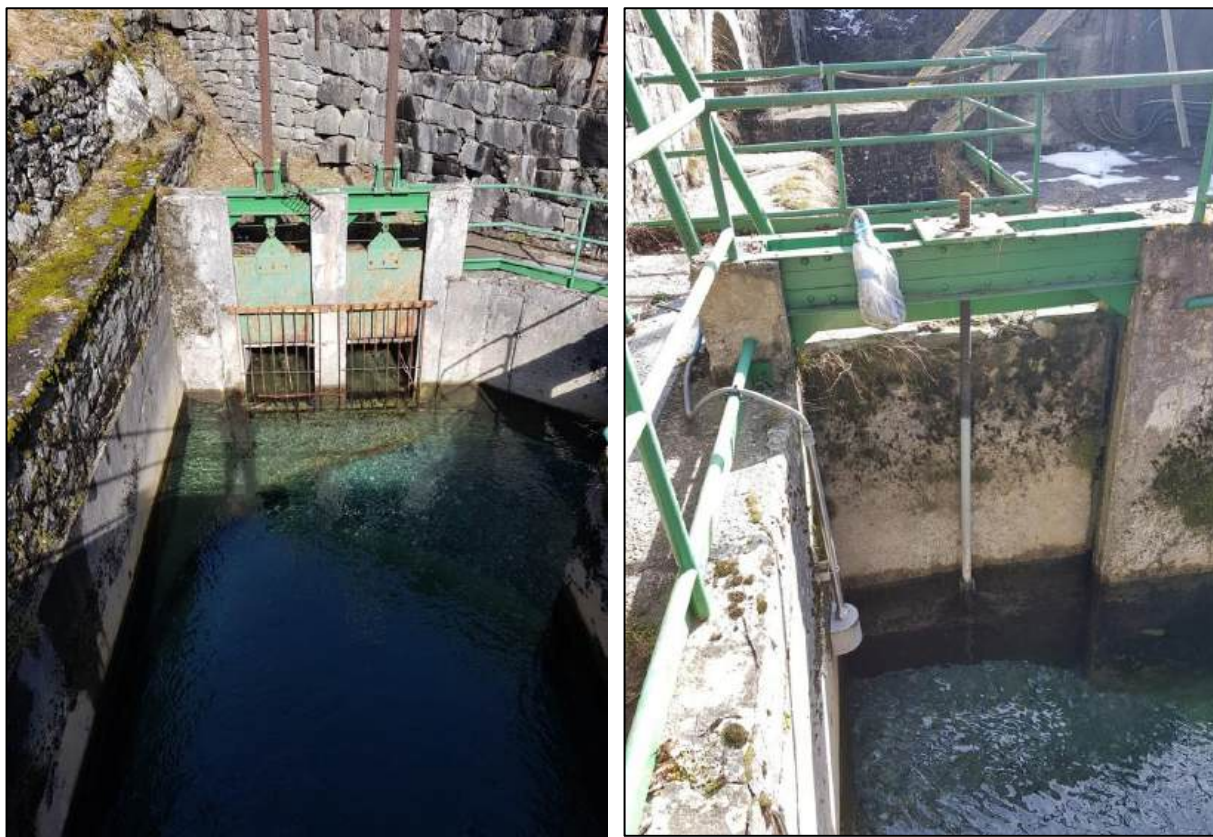
Figura 3.3.7: presa fiume Parma (residuo) – punto di presa con griglia di presa (foto a sx) e paratoia di scarico (foto a dx)
