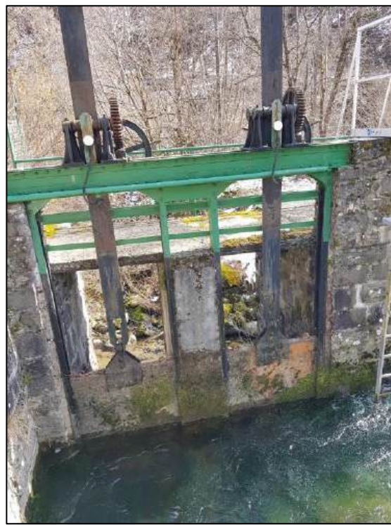
Figura 3.3.10: scarico impianto di Bosco di Corniglio – paratoie di presa (foto a sx) e di scarico (foto a dx)
