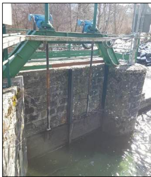
Figura 3.2.14: presa Parma del Lago Santo – paratoie di presa (foto a sx) e paratoie sghiaiatrici (foto a dx)
