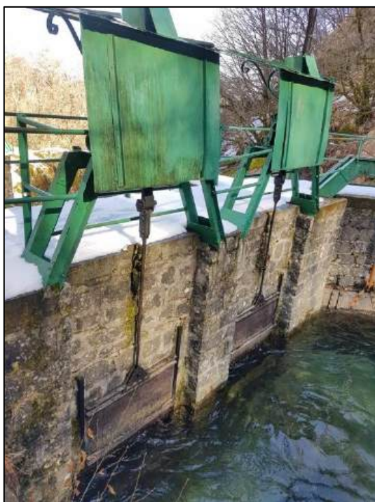
Figura 3.2.9: presa Parma di Francia – a sx lo sfioratore e la paratoia sghiaiatrice, a dx le due paratoie di presa
