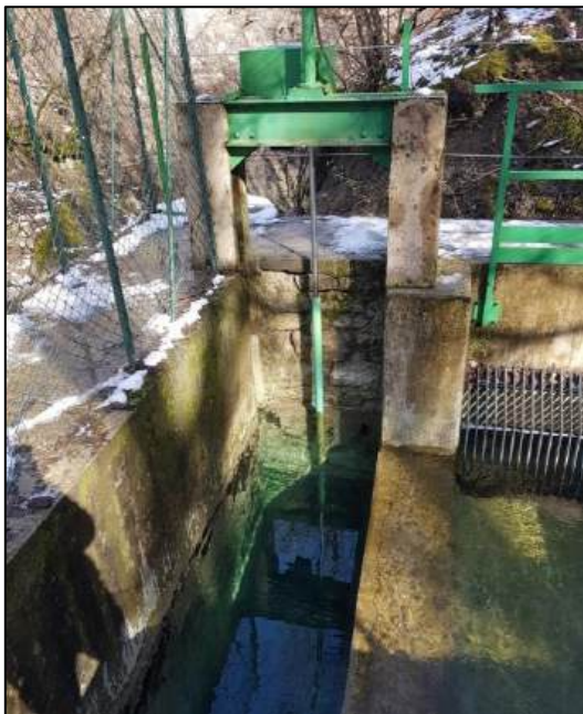
Figura 3.3.14: presa Roncovecchio – paratoia di scarico, vasca di decantazione (foto a sx) e presa con griglia (foto a dx)
