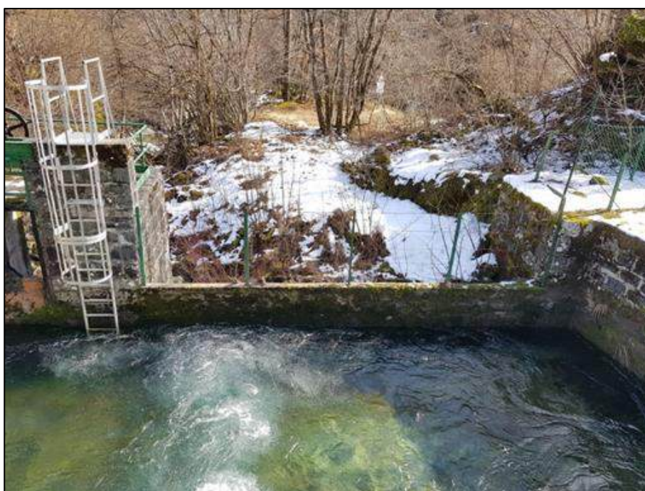
Figura 3.3.9: scarico impianto di Bosco di Corniglio – rappresentazione dello sfioratore del bacino
