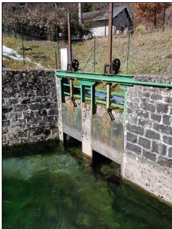
Figura 3.3.10: scarico impianto di Bosco di Corniglio – paratoie di presa (foto a sx) e di scarico (foto a dx)
