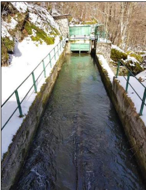
Figura 3.2.8: presa Parma di Badignana - vasca dissabbiatrice con relativi organi di scarico e di presa
