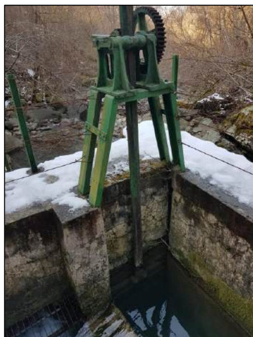
Figura 3.3.4: presa Rio Re – punto di presa con griglia di presa, vasca di decantazione, vasca di calma e paratoia sghiaiatrice
