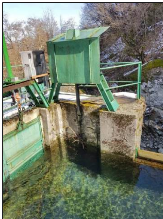
Figura 3.2.10: presa Parma di Francia – vasca dissabbiatrice con relativi organi di scarico e di presa
