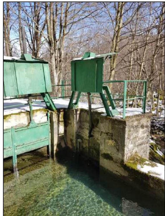
Figura 3.2.8: presa Parma di Badignana - vasca dissabbiatrice con relativi organi di scarico e di presa
