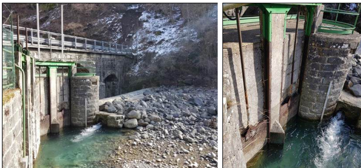
Figura 3.3.6: presa fiume Parma (residuo) – rappresentazione dello sbarramento (foto a sx) e delle due paratoie sghiaiatrici con in evidenza l'ingresso delle acque derivate dalla presa Rio Re (foto a dx)
