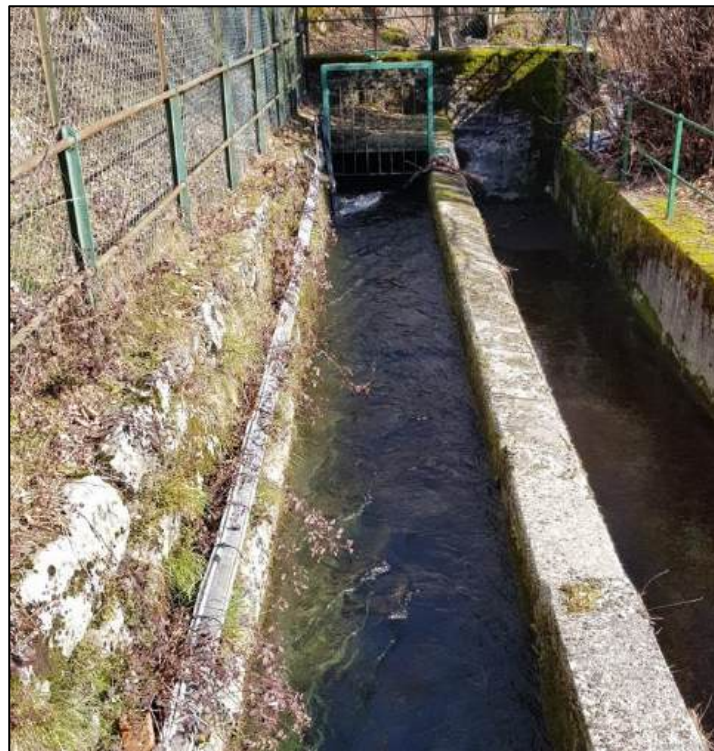
Figura 3.2.16: presa Parma del Lago Santo – primo tratto del canale derivatore a valle della vasca di decantazione
