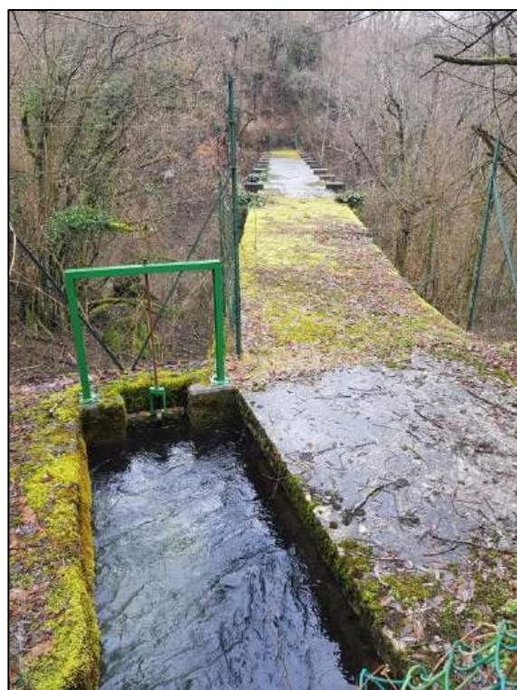
Figura 3.3.12: presa Rio della Costa – punto di presa con griglia (foto a sx) e seconda vasca di decantazione (foto a dx)
