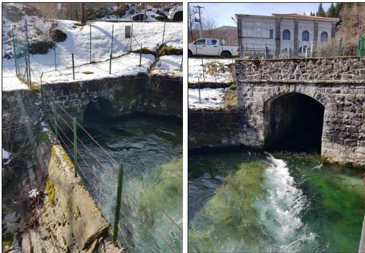
Figura 3.3.8: scarico impianto di Bosco di Corniglio – punti di ingresso delle acque derivate dal fiume Parma (residuo) e rilasciate dalla centrale di Bosco di Corniglio
