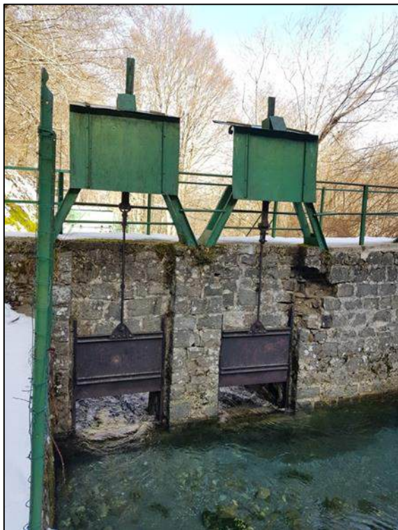
Figura 3.2.7: presa Parma di Badignana - opere di presa in sinistra idraulica (foto a sx); sempre in sinistra idraulica paratoie sghiaiatrici manuali (foto a dx)
