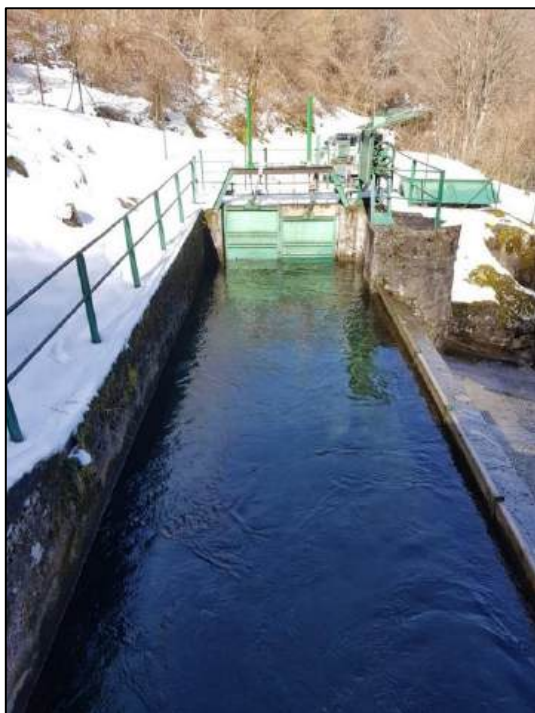
Figura 3.2.10: presa Parma di Francia – vasca dissabbiatrice con relativi organi di scarico e di presa
