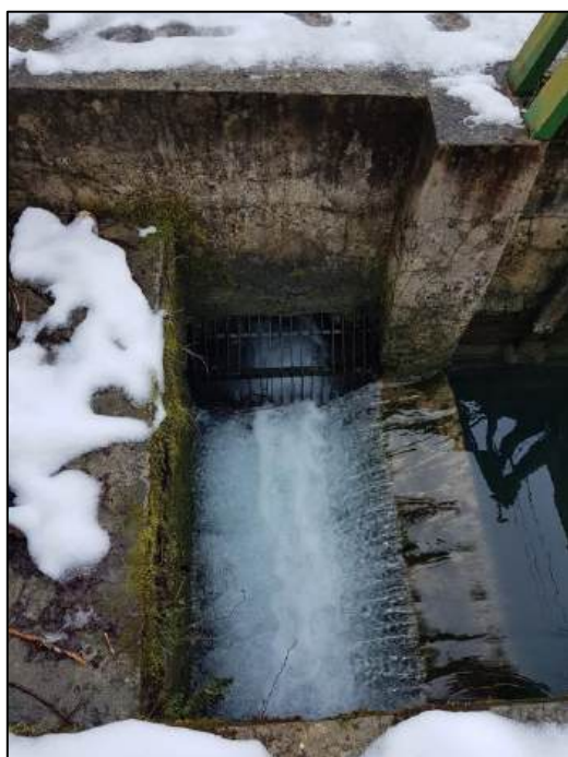
Figura 3.3.4: presa Rio Re – punto di presa con griglia di presa, vasca di decantazione, vasca di calma e paratoia sghiaiatrice
