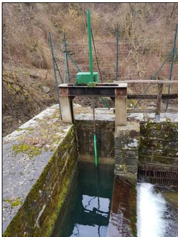
Figura 3.3.11: presa Rio della Costa – paratoia di scarico, vasca di decantazione e presa con griglia (foto a sx), sfioratore (foto a dx)
