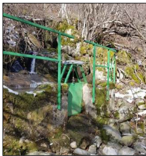
Figura 3.2.11: presa Rio Francia – vasca di decantazione con paratoia piana dissabbiatrice
