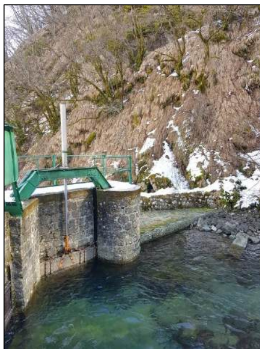
Figura 3.2.9: presa Parma di Francia – a sx lo sfioratore e la paratoia sghiaiatrice, a dx le due paratoie di presa
