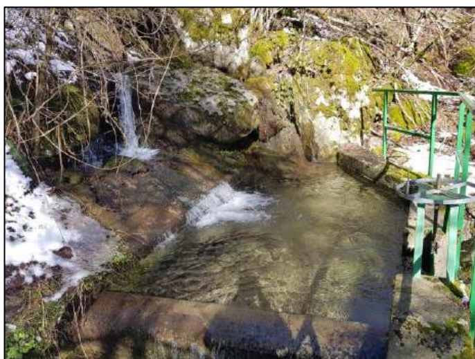
Figura 3.2.11: presa Rio Francia – vasca di decantazione con paratoia piana dissabbiatrice
