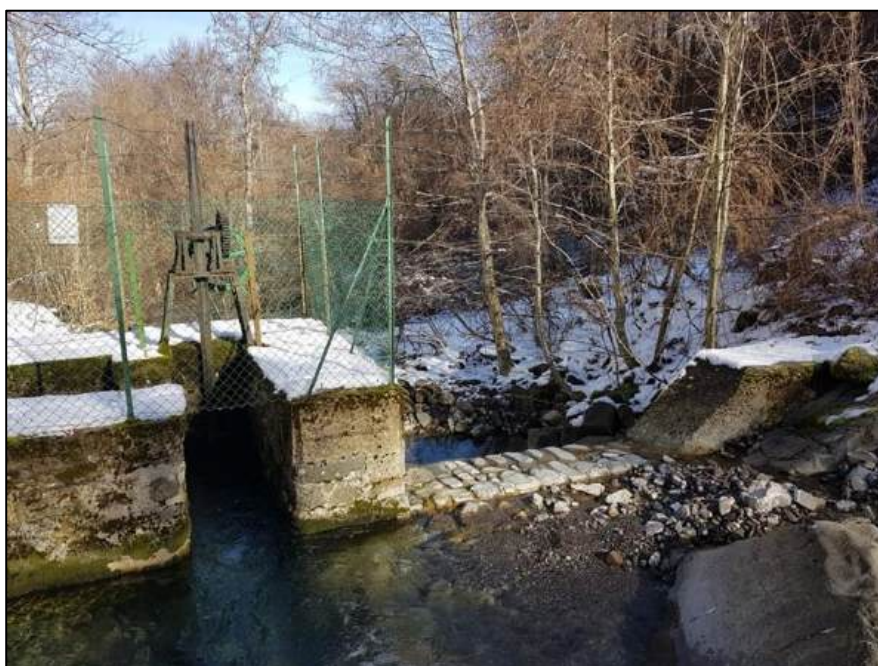
Figura 3.2.4: presa Rio della Sesta - A sinistra il punto di presa e a destra lo sfioratore.
