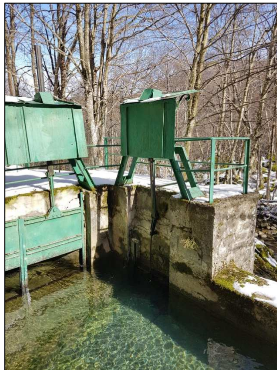
Figura 3-8: presa Parma di Badignana - vasca dissabbiatrice con relativi organi di scarico e di presa
