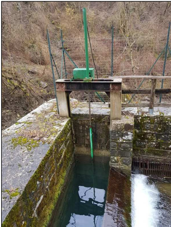
Figura 4-11: presa Rio della Costa – paratoia di scarico, vasca di decantazione e presa con griglia (foto a sx), sfioratore (foto a dx)
