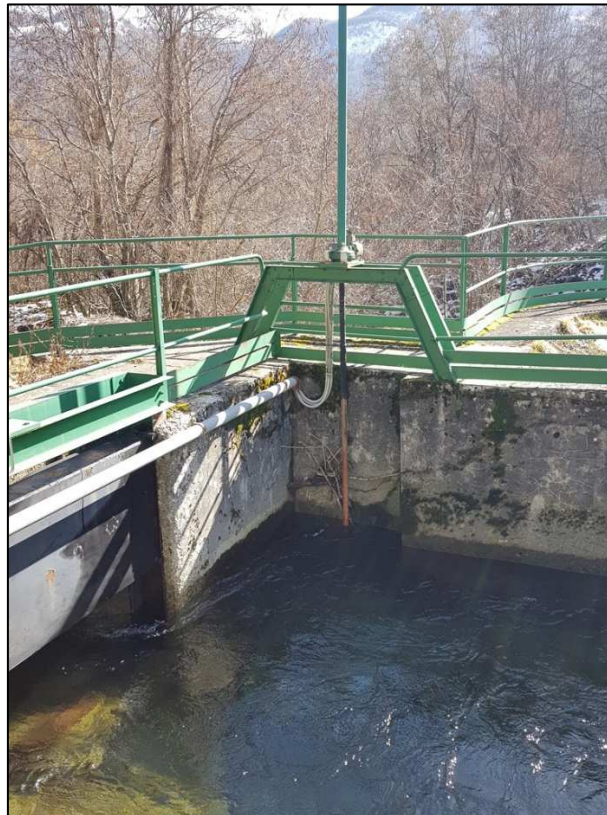
Figura 3-15: presa Parma del Lago Santo – vasca di decantazione con paratoia piana dissabbiatrice
