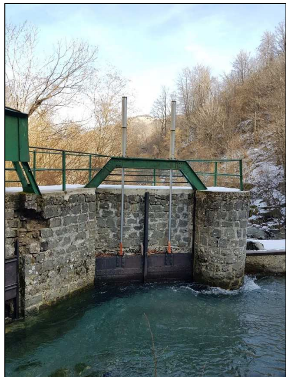
Figura 3-7: presa Parma di Badignana - opere di presa in sinistra idraulica (foto a sx); sempre in sinistra idraulica paratoie sghiaiatrici manuali (foto a dx)
