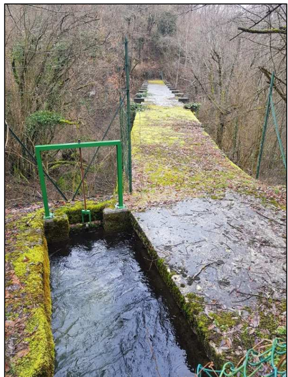
Figura 4-12: presa Rio della Costa – punto di presa con griglia (foto a sx) e seconda vasca di decantazione (foto a dx)
