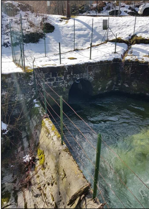
Figura 4-8: scarico impianto di Bosco di Corniglio – punti di ingresso delle acque derivate dal fiume Parma (residuo) e rilasciate dalla centrale di Bosco di Corniglio
