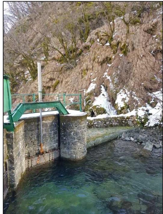
Figura 3-9: presa Parma di Francia – a sx lo sfioratore e la paratoia sghiaiatrice, a dx le due paratoie di presa
