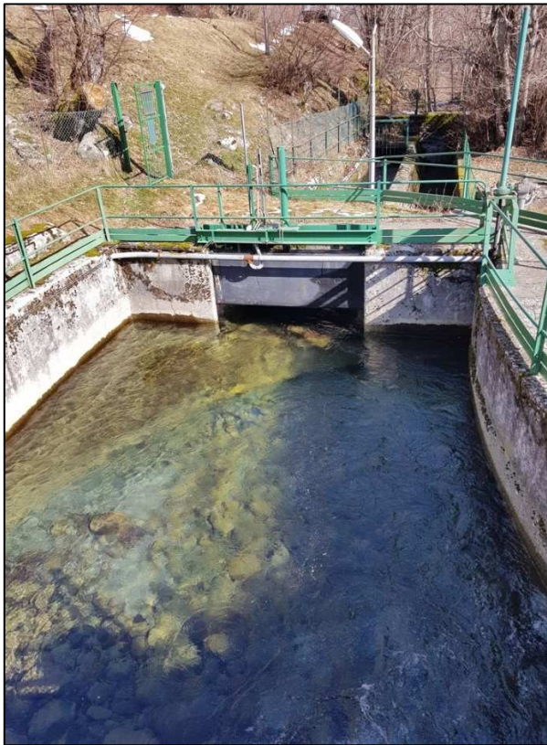
Figura 3-15: presa Parma del Lago Santo – vasca di decantazione con paratoia piana dissabbiatrice
