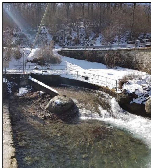
Figura 3-13: presa Parma del Lago Santo – sfioratore presa e arrivo canale da presa Parma di Francia
