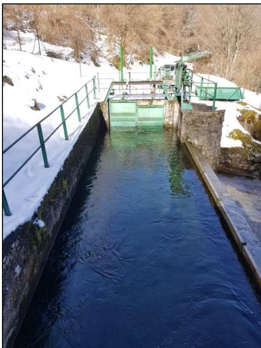
Figura 3-10: presa Parma di Francia – vasca dissabbiatrice con relativi organi di scarico e di presa
