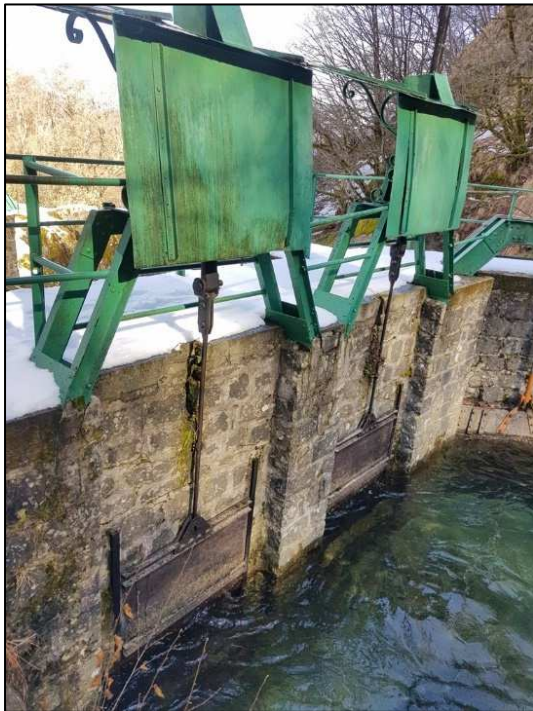
Figura 3-9: presa Parma di Francia – a sx lo sfioratore e la paratoia sghiaiatrice, a dx le due paratoie di presa
