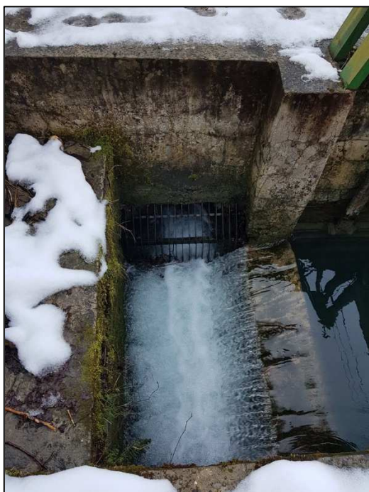
Figura 4-4: presa Rio Re – punto di presa con griglia di presa, vasca di decantazione, vasca di calma e paratoia sghiaiatrice
