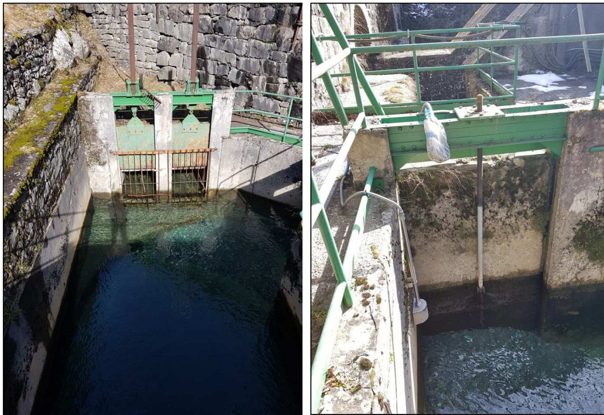
Figura 4-7: presa fiume Parma (residuo) – punto di presa con griglia di presa (foto a sx) e paratoia di scarico (foto a dx)
