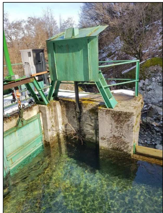
Figura 3-10: presa Parma di Francia – vasca dissabbiatrice con relativi organi di scarico e di presa
