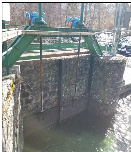
Figura 3-14: presa Parma del Lago Santo – paratoie di presa (foto a sx) e paratoie sghiaiatrici (foto a dx)
