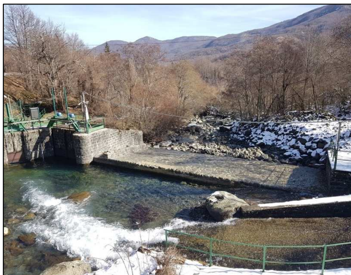
Figura 3-13: presa Parma del Lago Santo – sfioratore presa e arrivo canale da presa Parma di Francia
