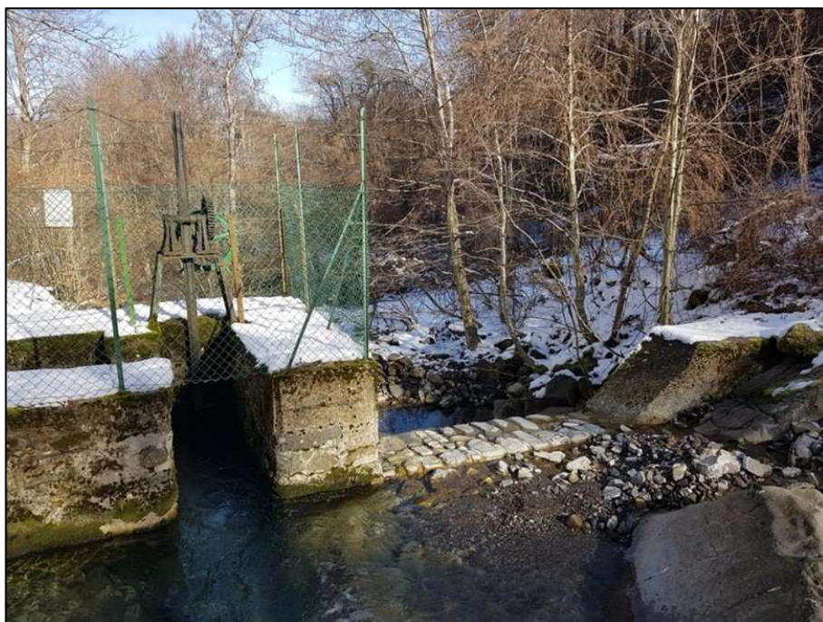
Figura 3-4: presa Rio della Sesta - A sinistra il punto di presa e a destra lo sfioratore.
