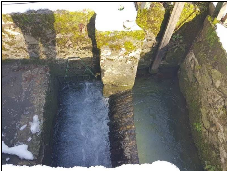
Figura 3-5: Rio della Sesta - punto di derivazione con vasca di decantazione.
