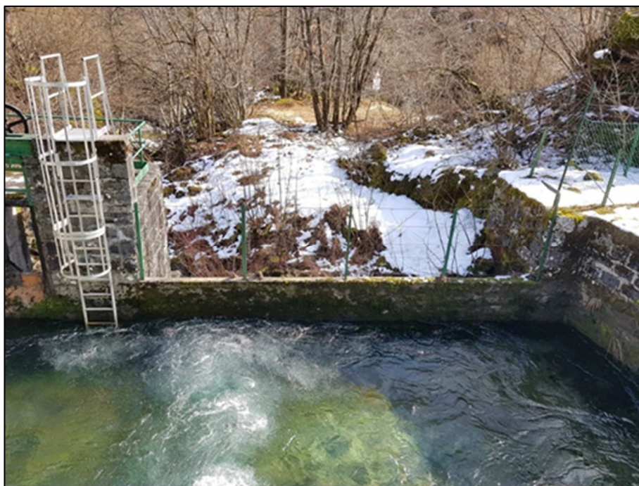
Figura 4-9: scarico impianto di Bosco di Corniglio – rappresentazione dello sfioratore del bacino
