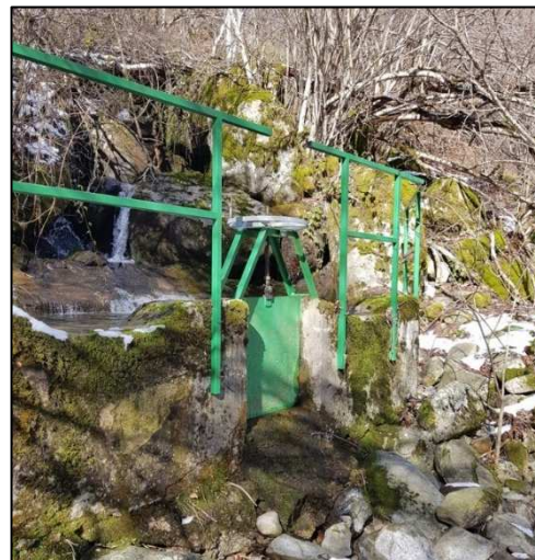
Figura 3-11: presa Rio Francia – vasca di decantazione con paratoia piana dissabbiatrice
