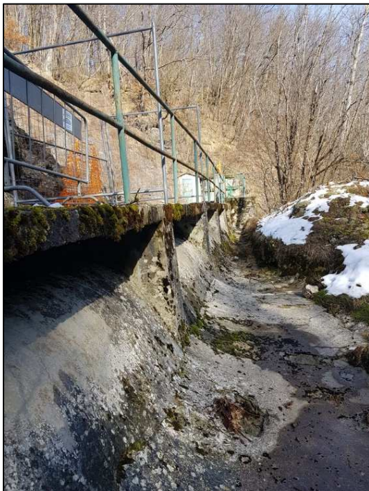
Figura 4-15: presa Roncovecchio – sfioratore sul ponte canale (foto a sx) e paratoia di scarico canale (foto a dx)
