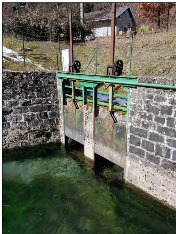
Figura 4-10: scarico impianto di Bosco di Corniglio – paratoie di presa (foto a sx) e di scarico (foto a dx)
