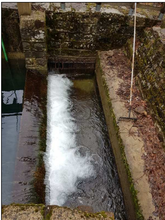
Figura 4-12: presa Rio della Costa – punto di presa con griglia (foto a sx) e seconda vasca di decantazione (foto a dx)
