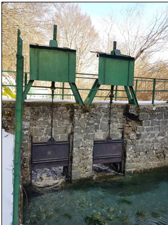
Figura 3-7: presa Parma di Badignana - opere di presa in sinistra idraulica (foto a sx); sempre in sinistra idraulica paratoie sghiaiatrici manuali (foto a dx)
