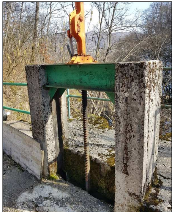
Figura 4-15: presa Roncovecchio – sfioratore sul ponte canale (foto a sx) e paratoia di scarico canale (foto a dx)
