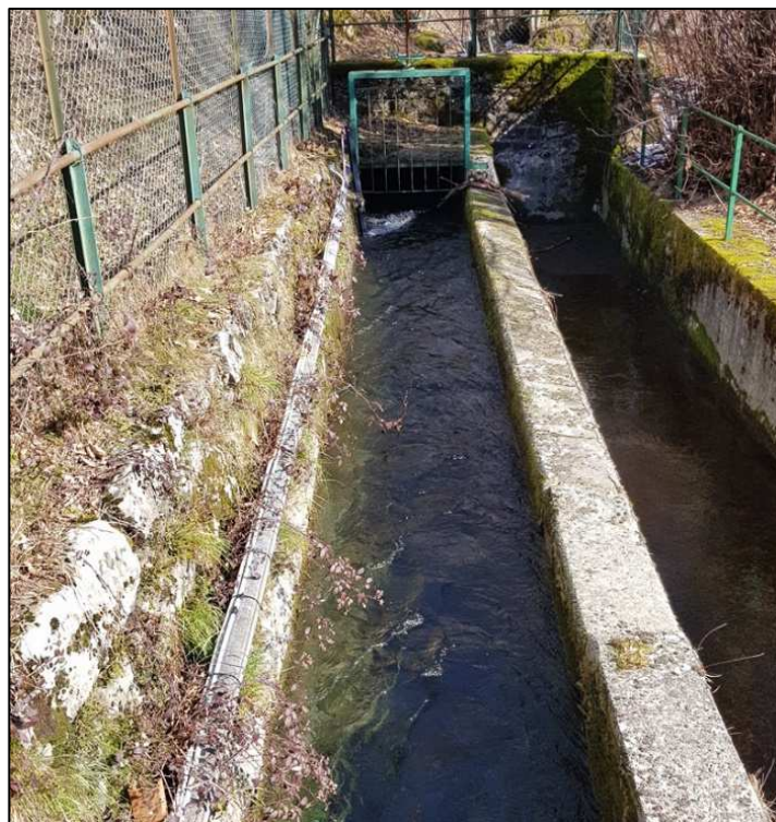
Figura 3-16: presa Parma del Lago Santo – primo tratto del canale derivatore a valle della vasca di decantazione
