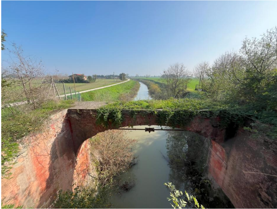
Figura 49- Vista dal punto 19. Manufatto idraulico. Vista canale Aldrovandi
