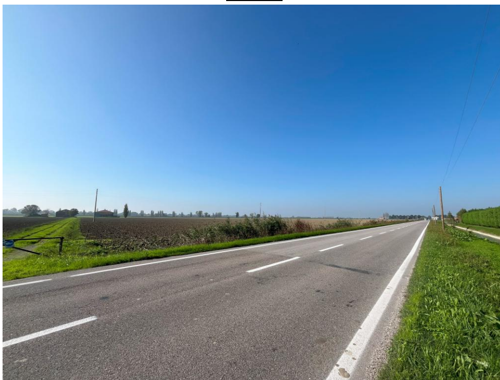
Figura 31- Vista dal Punto 1 dalla SP25, all'entrata dell'agriturismo La Torretta
