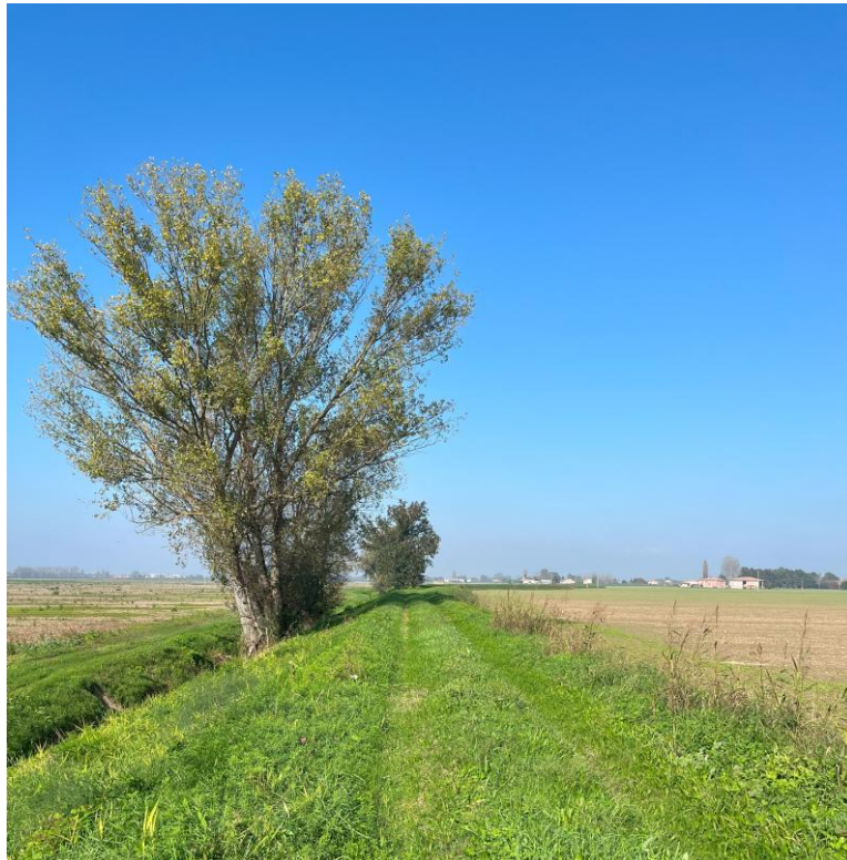
Figura 54- Vista dal punto 24 dalla strada storica panoramica. Alberature sul Canale Riazzo
