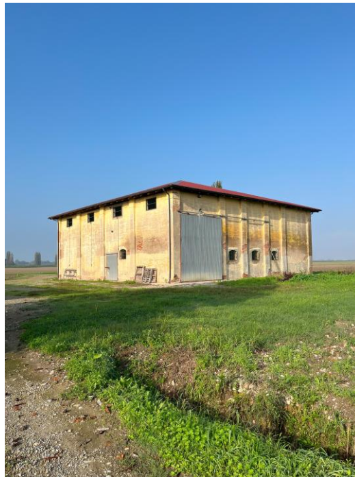
Figura 35- Vista dal punto 5. Manufatto rurale adibito a deposito
