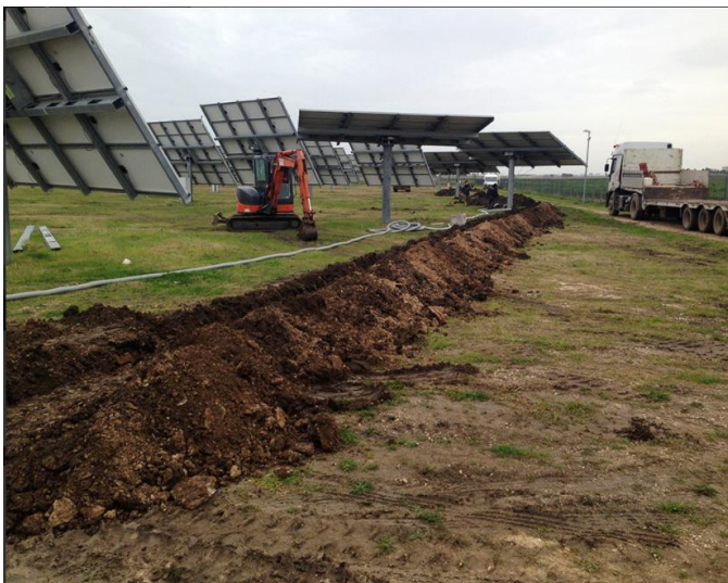
Figura 67- Esempio scavo trincee
