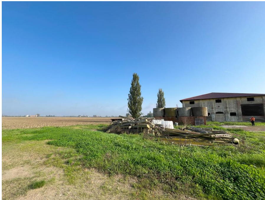
Figura 36- Vista dal punto 6. Pertinenze del manufatto rurale adibito a deposito
