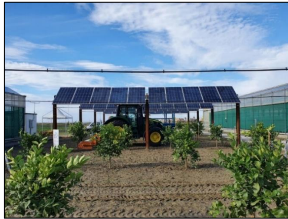
Figura 11- Rappresentazione di sinergia tra impianto energetico ed attività agricola Moduli fotovoltaici e tracker
