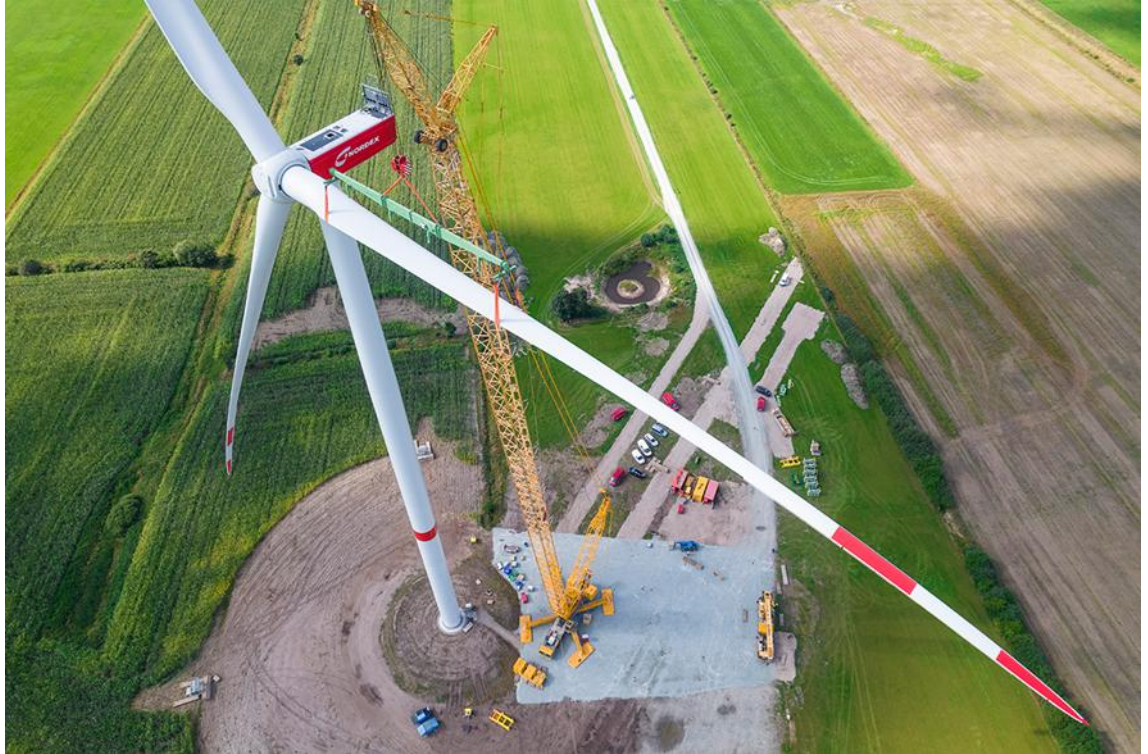
Figura 3.2.a Aerogeneratore in fase di montaggio
