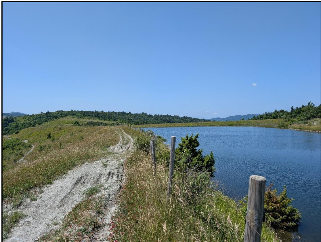
Figura 2.1.i Vista del Lago di Montecuccoli presente tra gli aerogeneratori F01 e F05, in secondo piano sulla dx la strada esistente che sarà riqualificata per l'accesso alla F01
