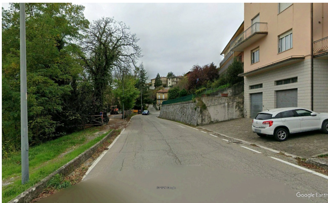
Esempio di alberature da potare verso strada
