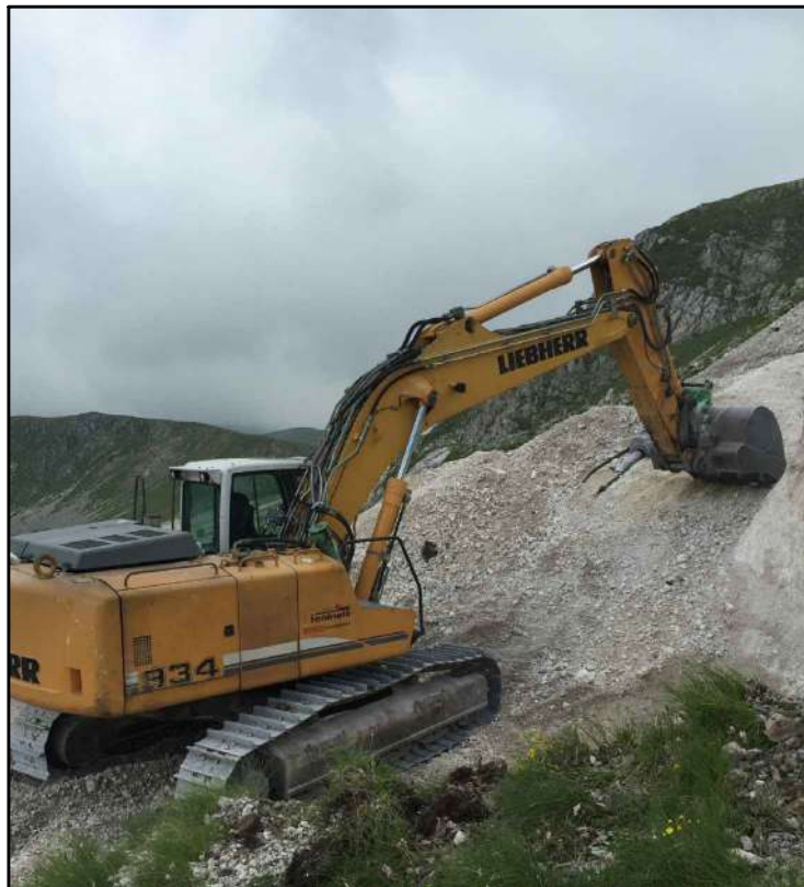
Scavo per plinti dei sostegni
