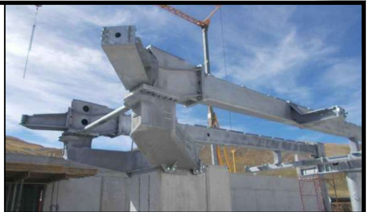
Montaggio stele anteriore di stazione
