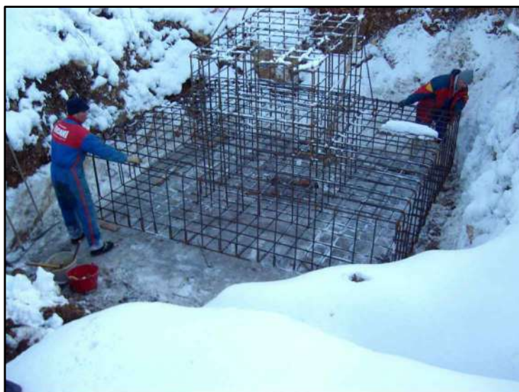
Posa dei ferri di armatura
