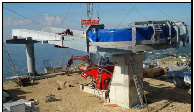
Montaggio travi e parti metalliche di supporto per opere elettromeccaniche
