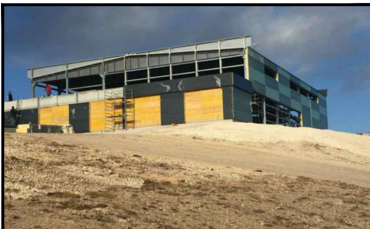
Montaggio carpenterie metalliche
