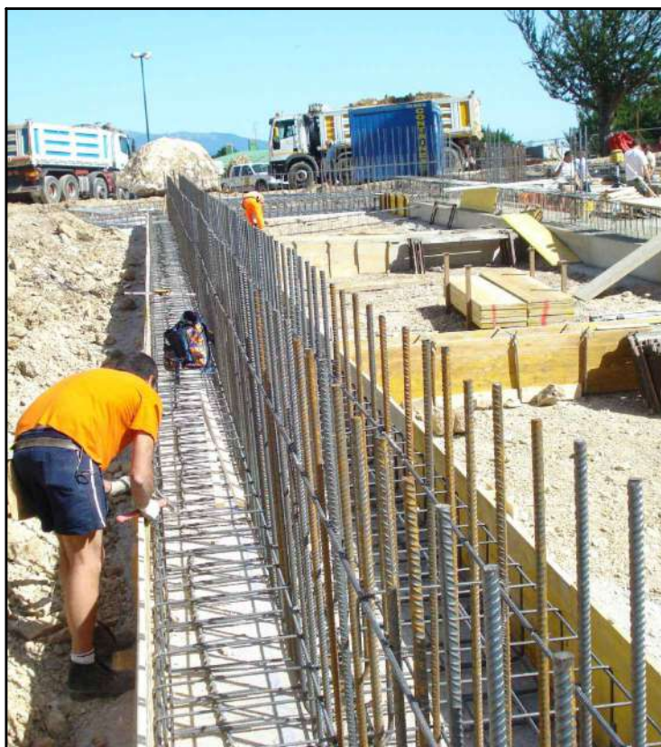
Posa dei ferri di armatura
