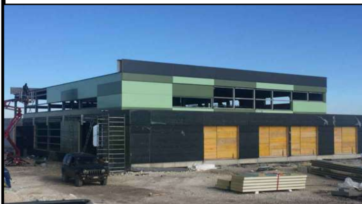
Montaggio facciate
