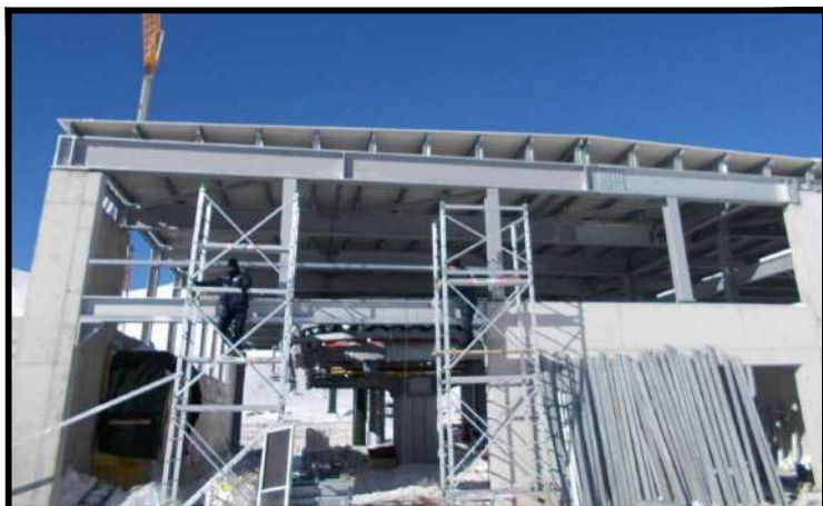
Montaggio carpenterie metalliche
