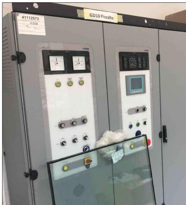
Installazione quadri elettrici cabina di comando
