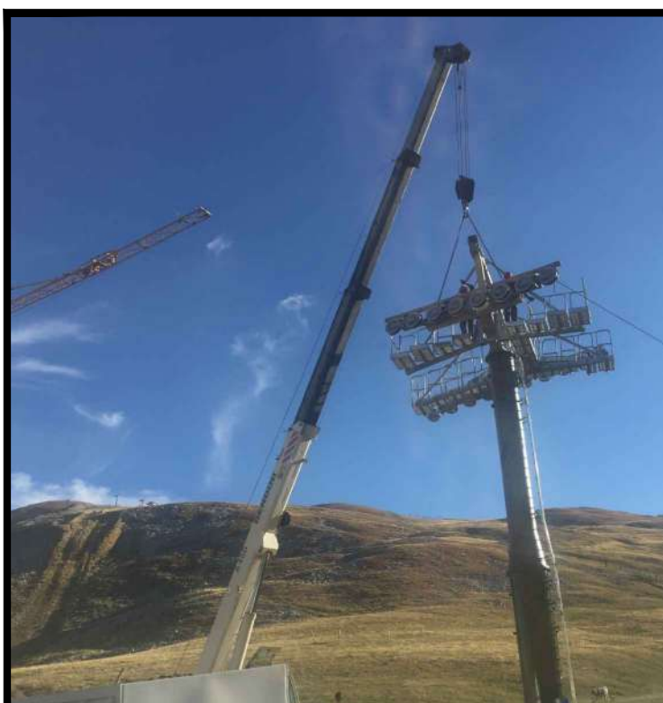
Montaggio sostegni con autogru
