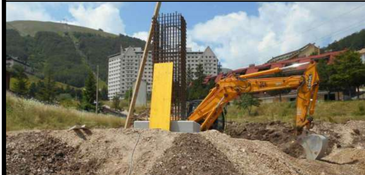
Posa dei ferri di armatura
