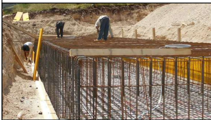
Posa dei ferri di armatura
