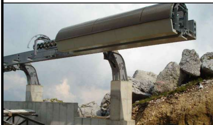
Montaggio travi e parti metalliche di supporto per opere elettromeccaniche
