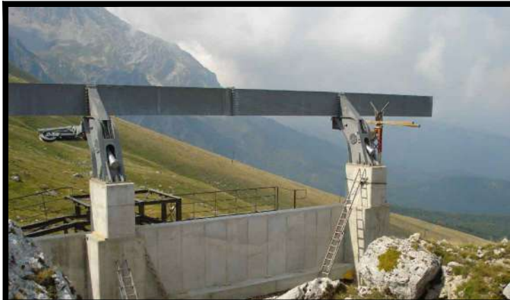
Montaggio sostegno di linea (in stazione)
