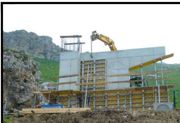
Posa dei ferri di armatura
