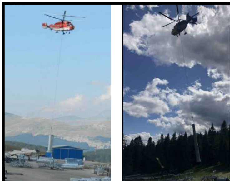
Montaggio sostegni con elicottero
