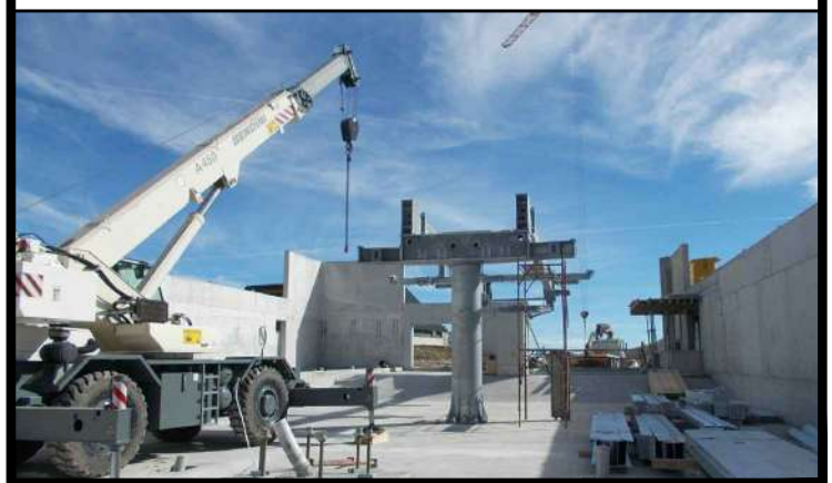
Montaggio stele anteriore di stazione
