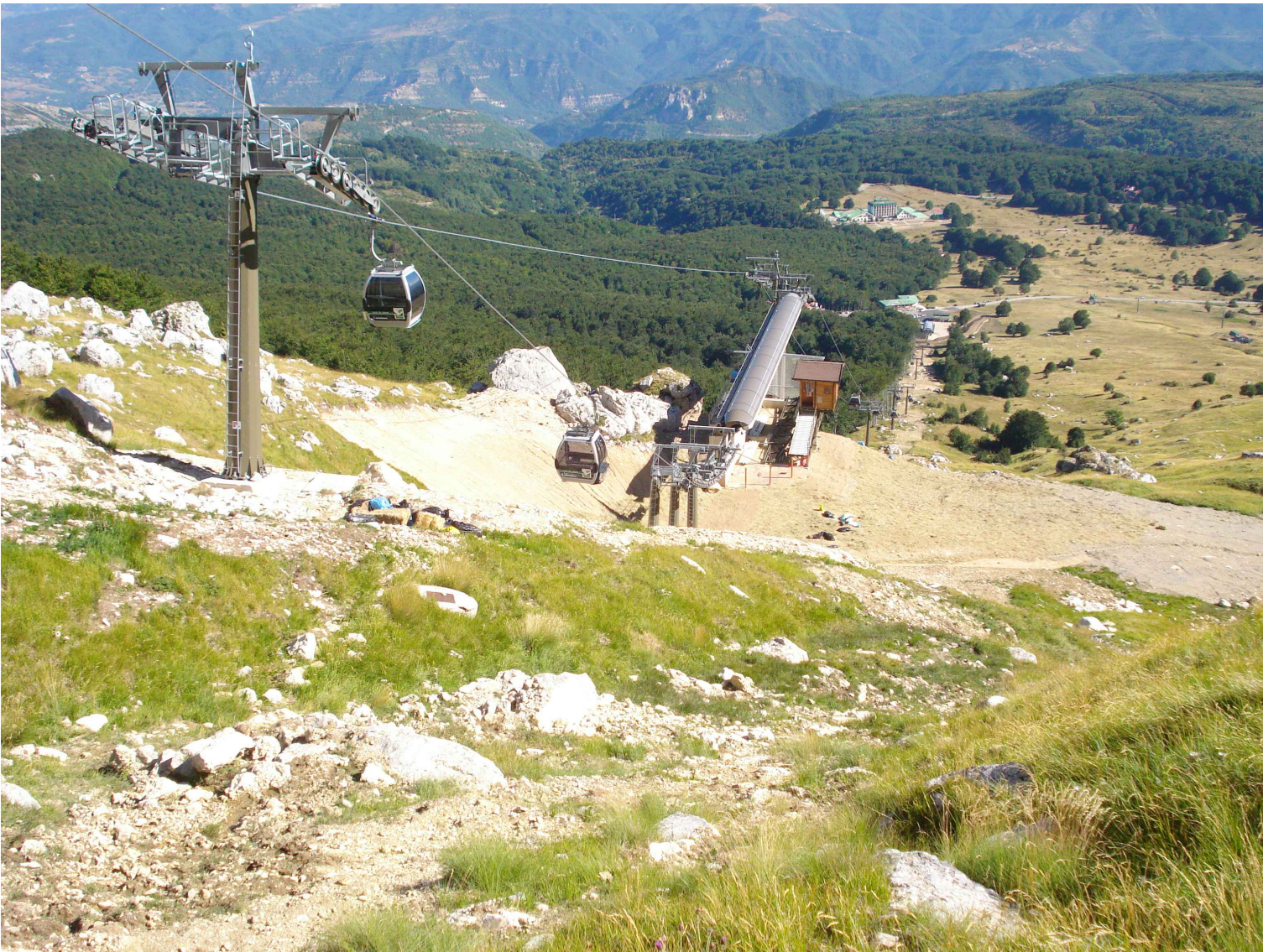
FOTO 2 - ESEMPIO DI STAZIONE INTERMEDIA
