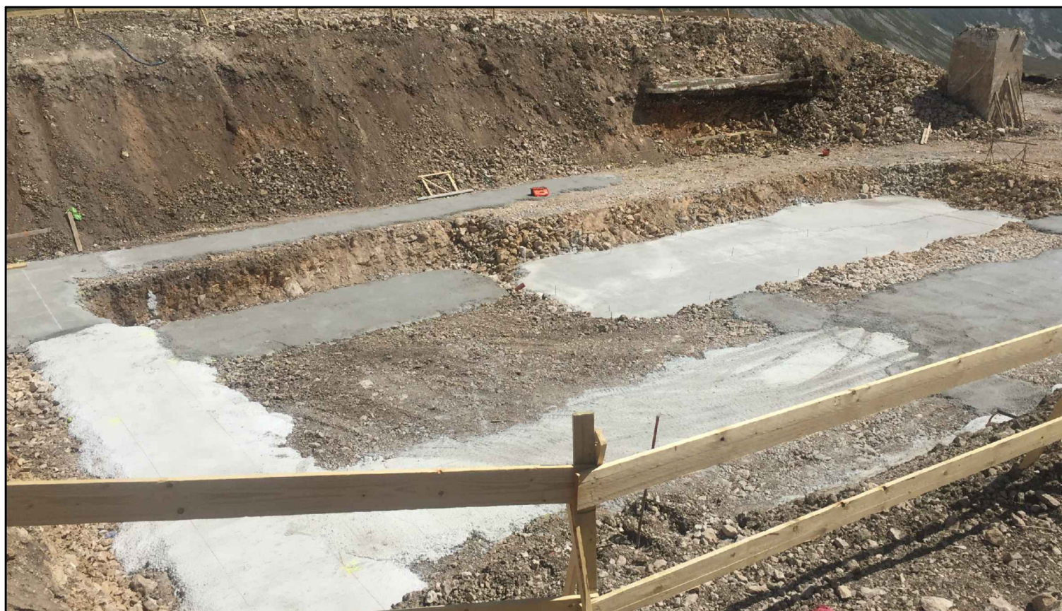
Scavo piano di posa fondazioni edifici di stazione
