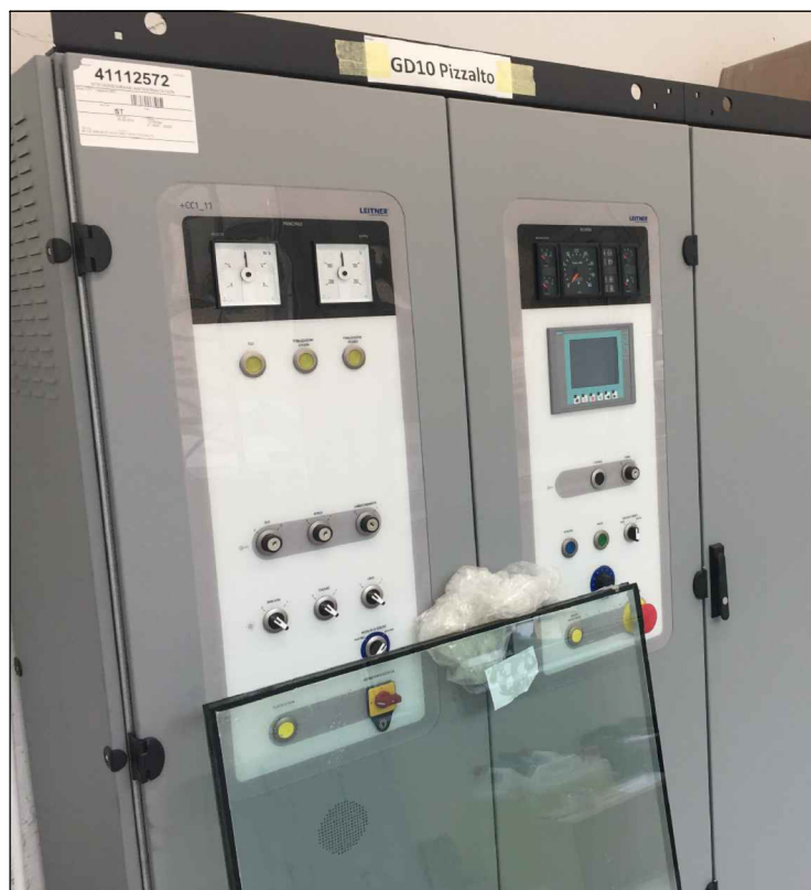
Installazione quadri elettrici cabina di comando
