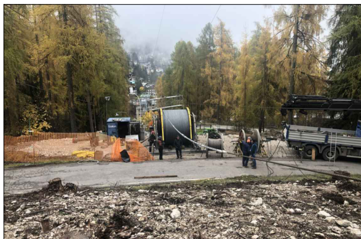
Collegamento alla fune imbobinata
