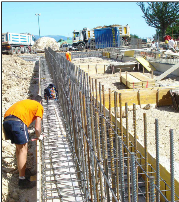
Posa dei ferri di armatura
