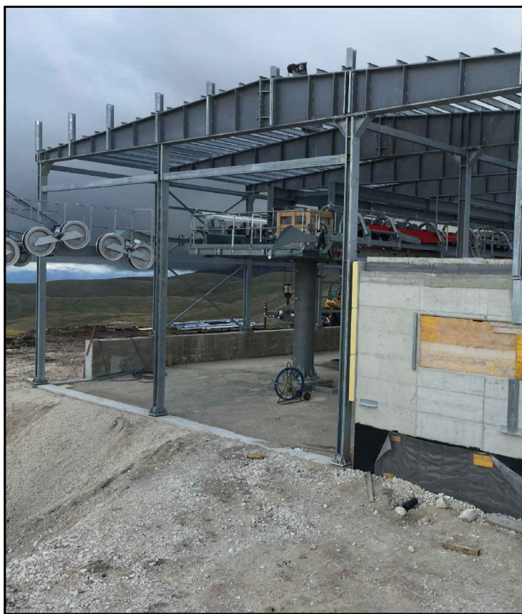
Montaggio carpenterie metalliche
