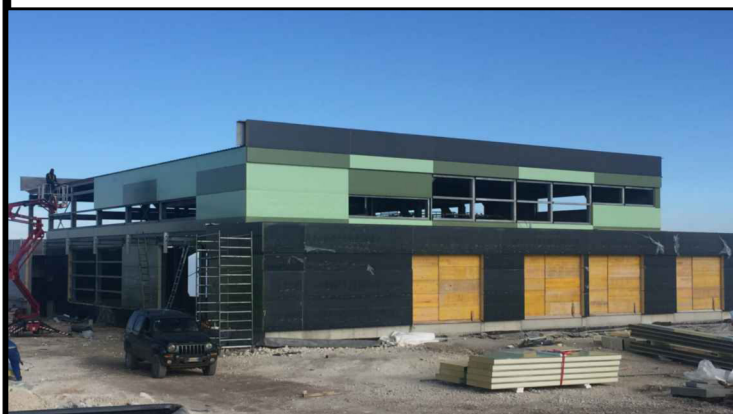
Montaggio facciate
