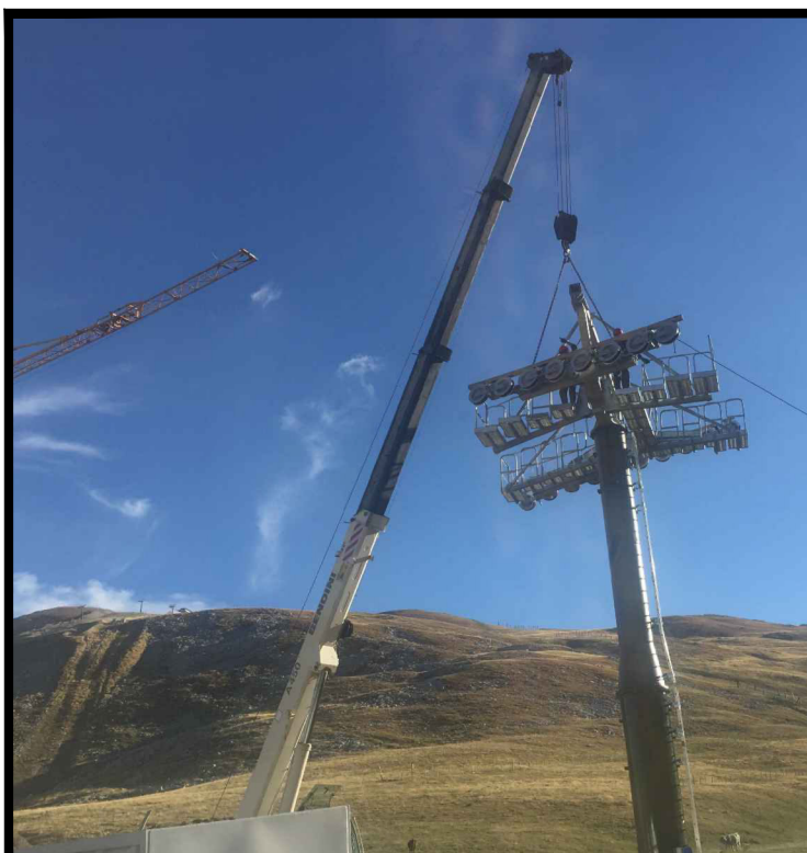
Montaggio sostegni con autogru
