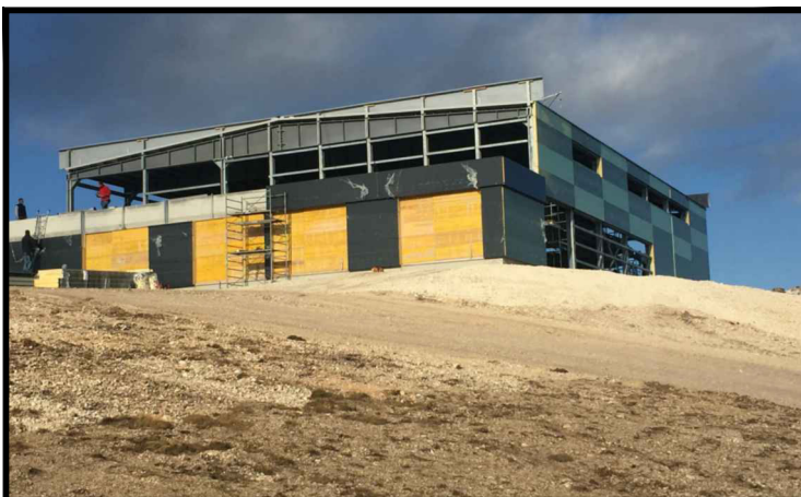
Montaggio carpenterie metalliche
