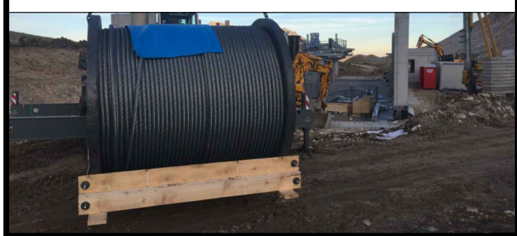
Posizionamento fune guida
