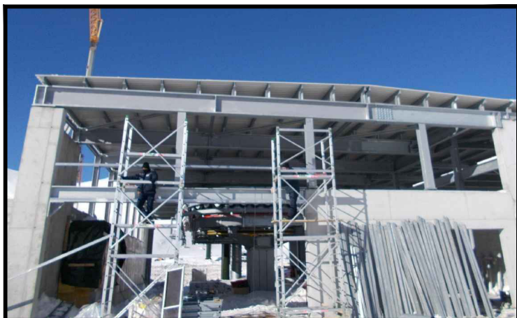
Montaggio carpenterie metalliche
