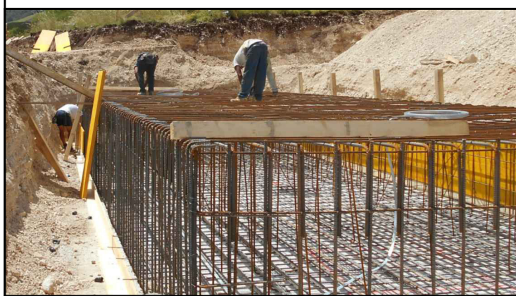
Posa dei ferri di armatura
