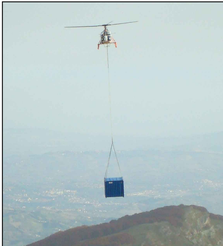
Installazione attrezzature da cantiere
