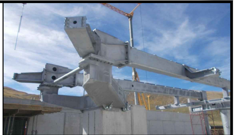
Montaggio stele anteriore di stazione
