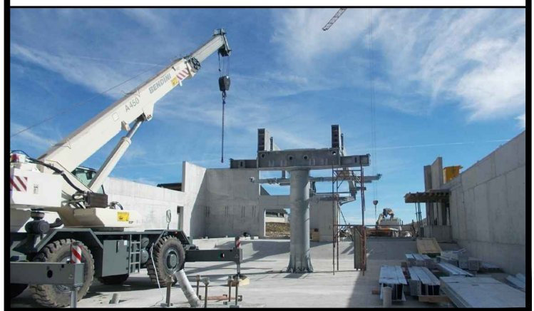
Montaggio stele anteriore di stazione
