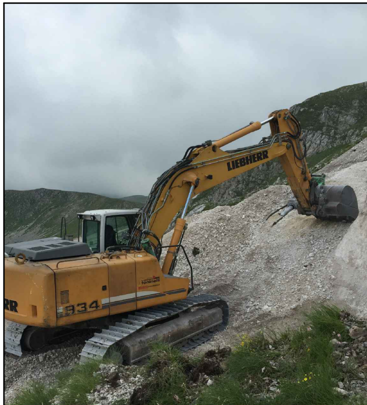
Scavo per plinti dei sostegni
