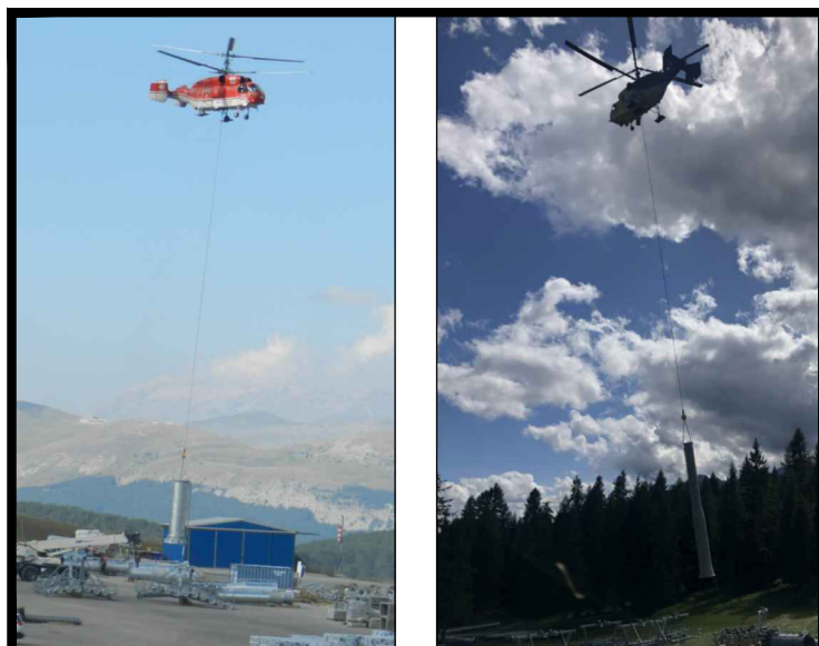
Montaggio sostegni con elicottero
