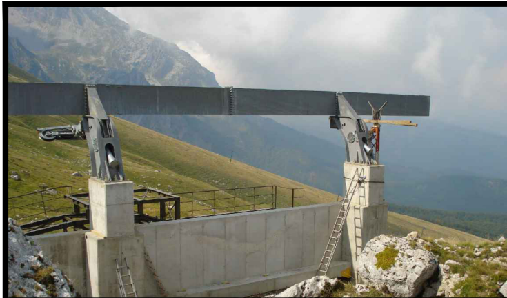
Montaggio sostegno di linea (in stazione)
