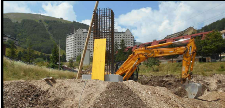
Posa dei ferri di armatura
