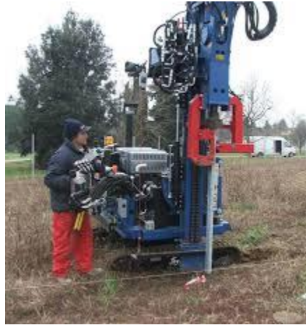
Foto n°2: Particolare infissione dei pali di fondazione dei pannelli fotovoltaici
