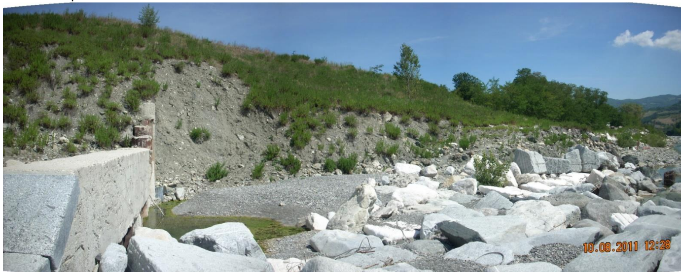
Danni alla scala di risalita dei pesci ed alla rampa in massi
