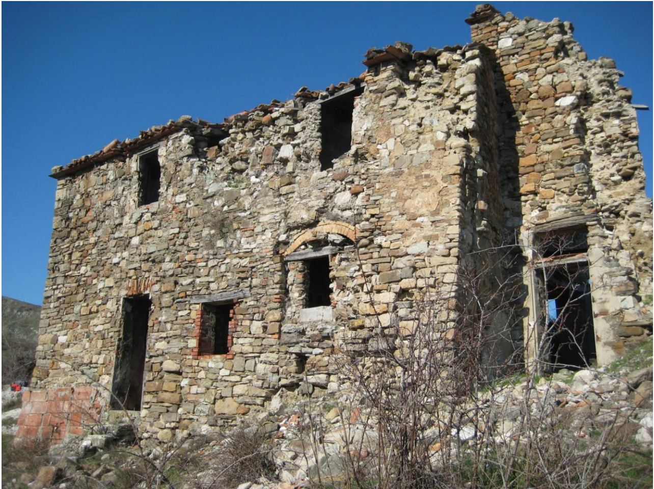
Fig. 29 – Ca’ Sassatello in val Sillaro, presso il margine occidentale della Vena del Gesso. Nonostante la casa sorge su substrato gessoso, essa è costruita con arenarie provenienti dalle vicine Argille Scagliose (foto S. Piastra).
