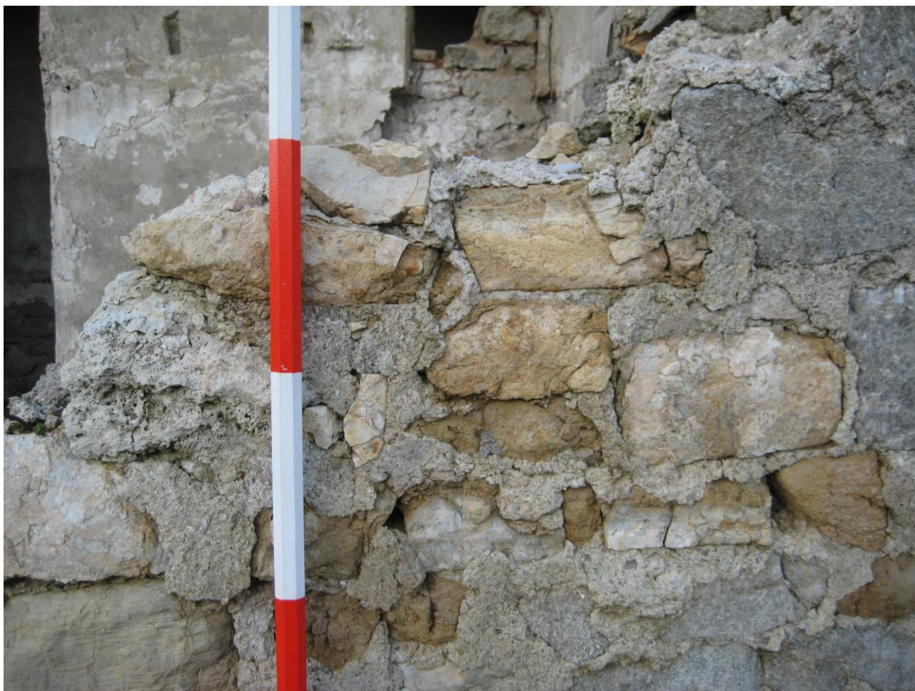
Fig. 31 – Particolare di una muratura di Ca' Castellina: il legante utilizzato è gesso cotto, macinato in maniera grossolana (foto S. Piastra).
