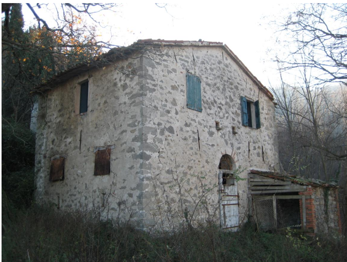
Fig. 9 – Uno degli edifici del nucleo di Ca’ di Sotto (Monte Mauro) (tipo imolese-faentino): al piano terra le stalle con aperture quadrangolari e relativi portelli metallici; al primo piano le camere da letto. La scala di accesso è interna al fabbricato (foto S. Piastra).
