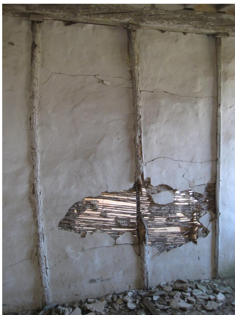
Fig. 35 (sopra) – Incannucciato impastato con gesso cotto per controsoffittare il tetto. Ca' Castellina (foto S. Piastra).
