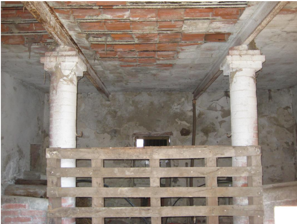
Fig. 10 – Stalla con soffitto piatto e colonnine in mattoni semicircolari in un edificio del nucleo di Ca' di Sotto (Monte Mauro) (foto S. Piastra).
