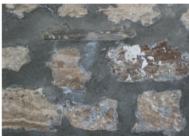
Figg. 25-28 – Da in alto a sinistra, in senso orario, blocco in gesso selenitico dalle murature di Ca’ Castellina (foto S. Piastra); concrezioni gessose dalle murature di Ca’ Monti (foto S. Piastra); karren in formazione nelle murature di una casa rurale presso Pieve di Gesso (foto M. Sami); blocchi di “gesso color miele”, Crivellari (foto S. Piastra);.
