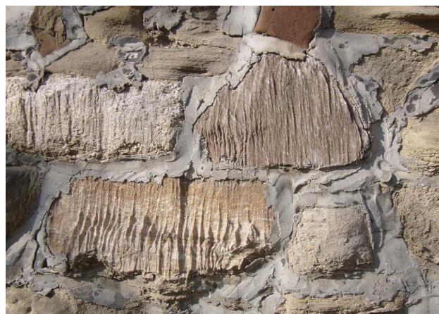
Figg. 25-28 – Da in alto a sinistra, in senso orario, blocco in gesso selenitico dalle murature di Ca’ Castellina (foto S. Piastra); concrezioni gessose dalle murature di Ca’ Monti (foto S. Piastra); karren in formazione nelle murature di una casa rurale presso Pieve di Gesso (foto M. Sami); blocchi di “gesso color miele”, Crivellari (foto S. Piastra);.
