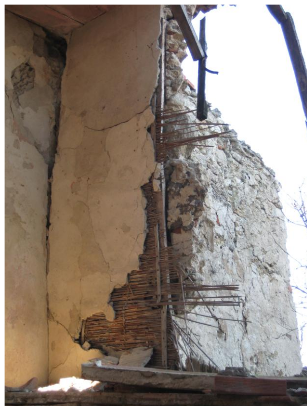
Figg. 81-84 – Ca' Poggio Benati. Da in alto a sinistra, in senso orario, le stalle; il fienile addossato sul retro, con un particolare arco a tutto sesto; un tramezzo in graticcio con incannucciata impastata assieme a gesso cotto; ciò che resta di un camino interno (foto S. Piastra).
