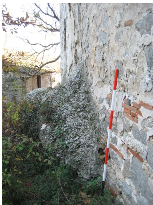
Fig. 23 – Casa-torre appartenente al nucleo di Ca' di Sotto (Monte Mauro), poggianti direttamente su substrato gessoso (foto S. Piastra).
