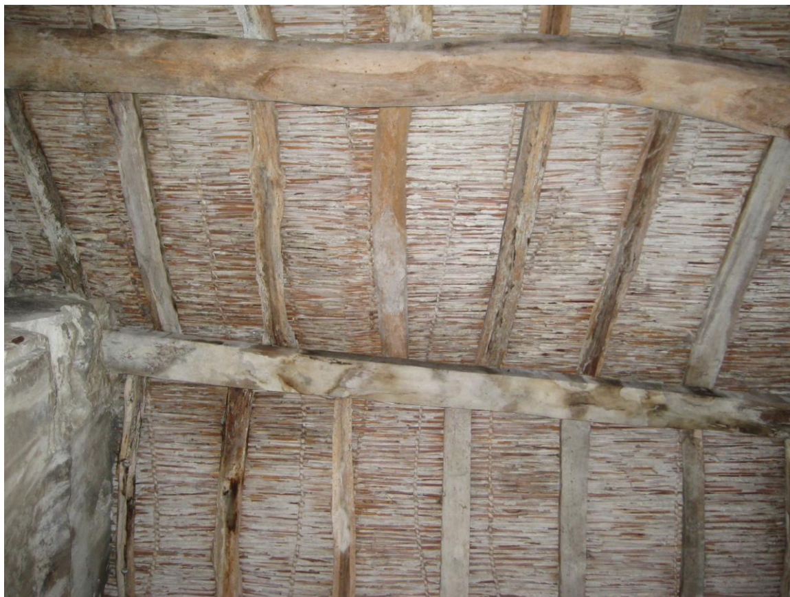
Fig. 35 (sopra) – Incannucciato impastato con gesso cotto per controsoffittare il tetto. Ca' Castellina (foto S. Piastra).
