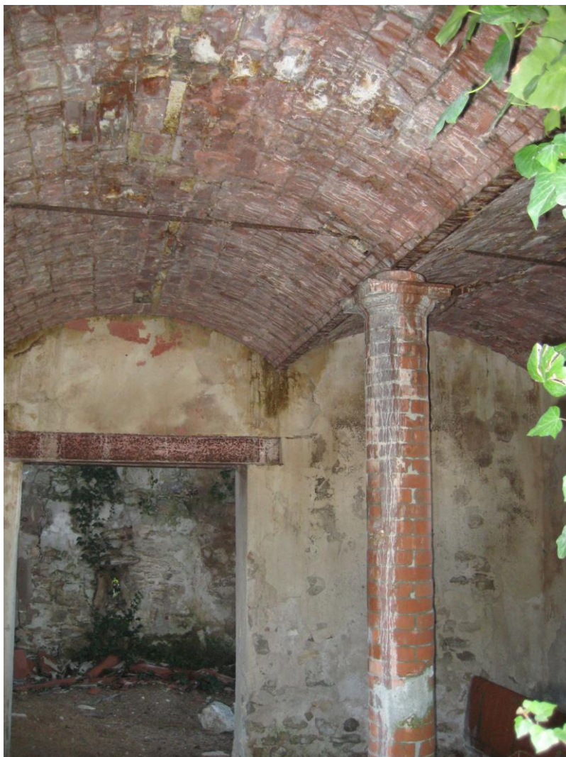
Fig. 11 – Stalla con volta a botte e colonnine in mattoni semicircolari a Ca' Poggio Oriani, tra Santerno e Senio (foto S. Piastra).
