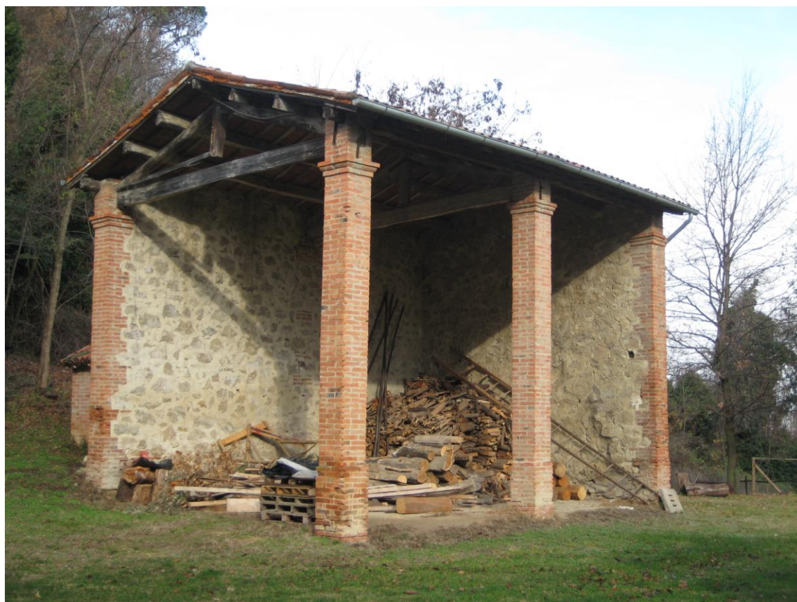
Fig. 20 – Fienile presso la chiesa parrocchiale di Rontana (Brisighella): muro posteriore in blocchi di gesso; pilastri anteriori in laterizi (foto S. Piastra).
