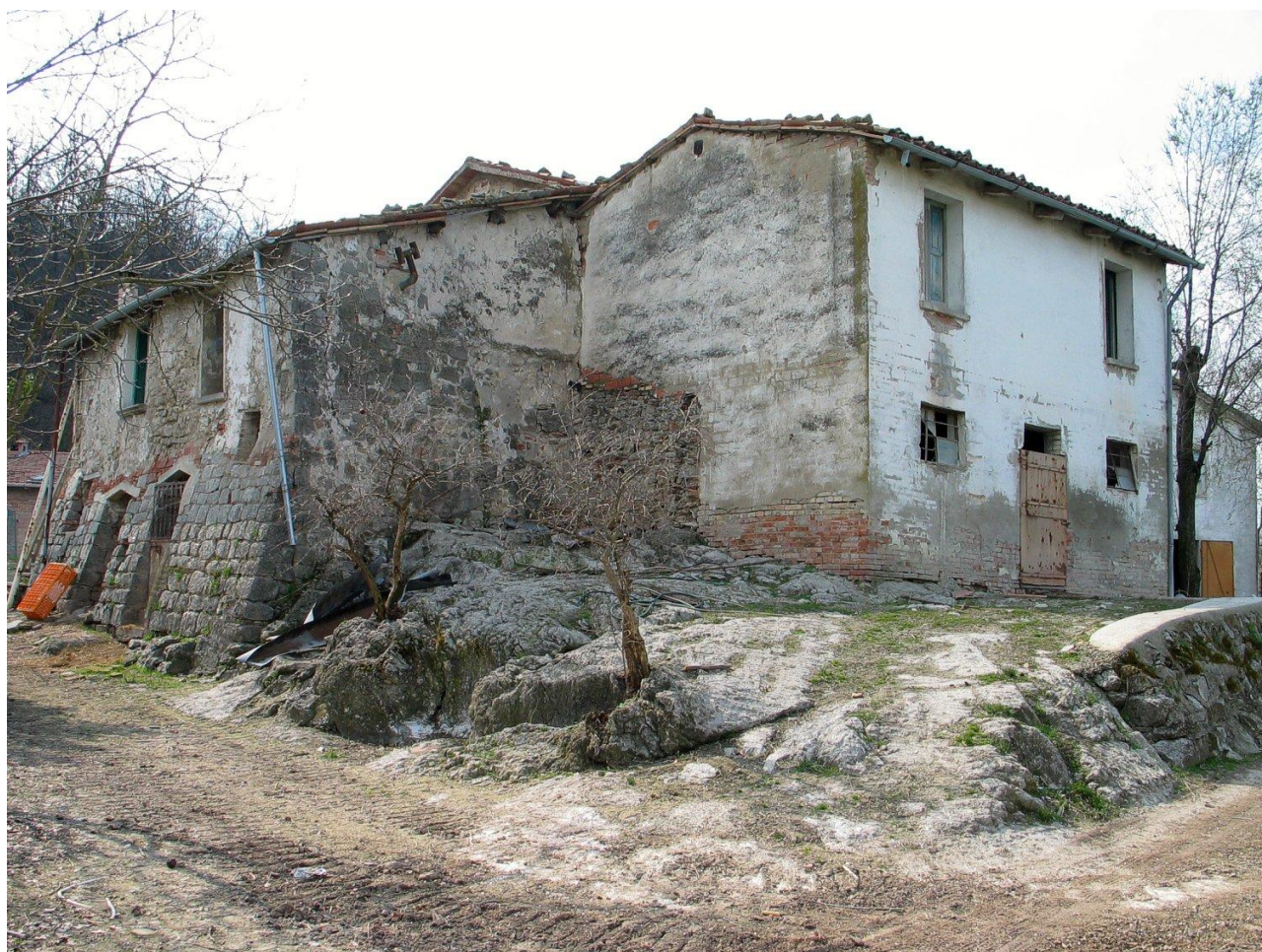
Fig. 3 – Ca' La Villa, lungo la vallecchia del rio Ferrato (versante nord di Monte Mauro). Sulla sinistra è visibile un muro a scarpa costruito in blocchi di gesso, verosimilmente riferibile ad una fortificazione dell'abitazione tra Medioevo e prima età moderna (foto P. Lucci).
