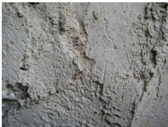
Fig. 32 – Particolare dell'intonaco in polvere di gesso di una parete interna di Ca' Castellina (foto S. Piastra).
