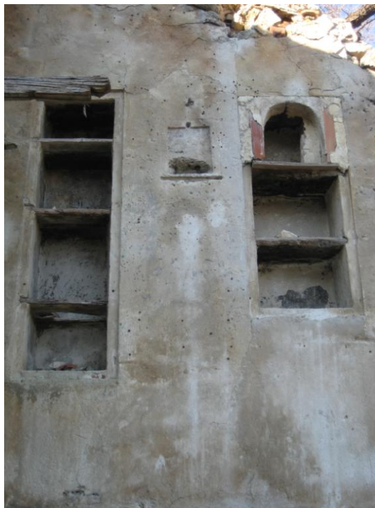
Fig. 78 – Ca' Morara: mensole e ripiani ricavati nelle murature (foto S. Piastra).
