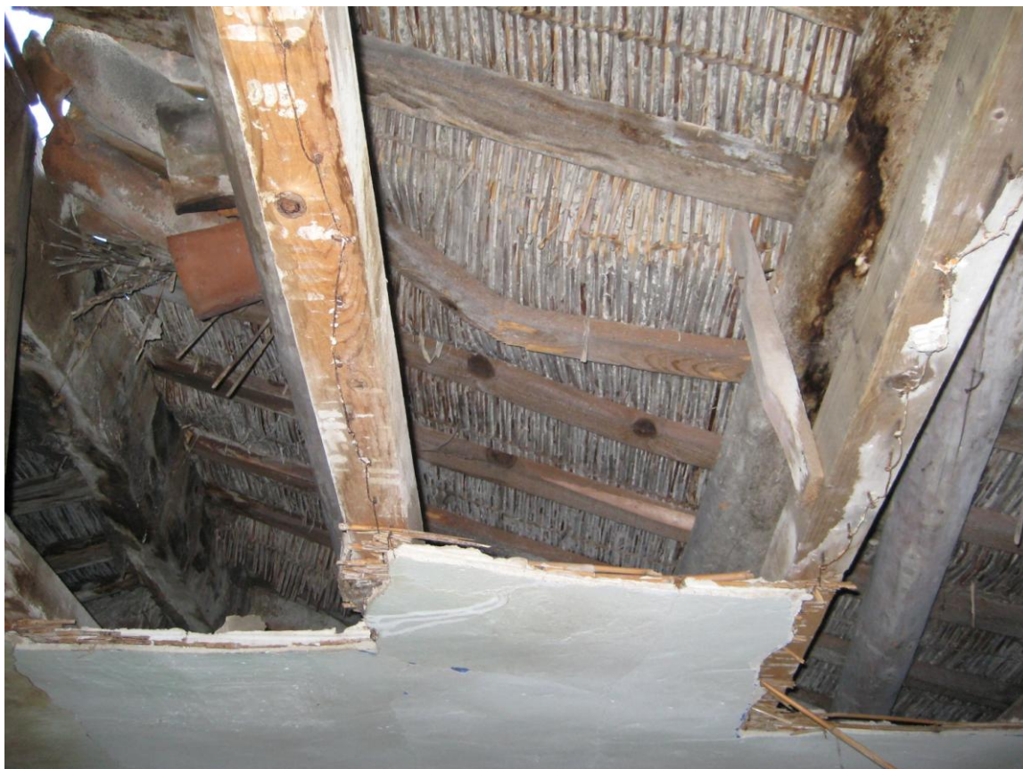
Fig. 72 – Ca' Castellina: controsoffitto in incannucciata impastata con gesso cotto (foto S. Piastra).
