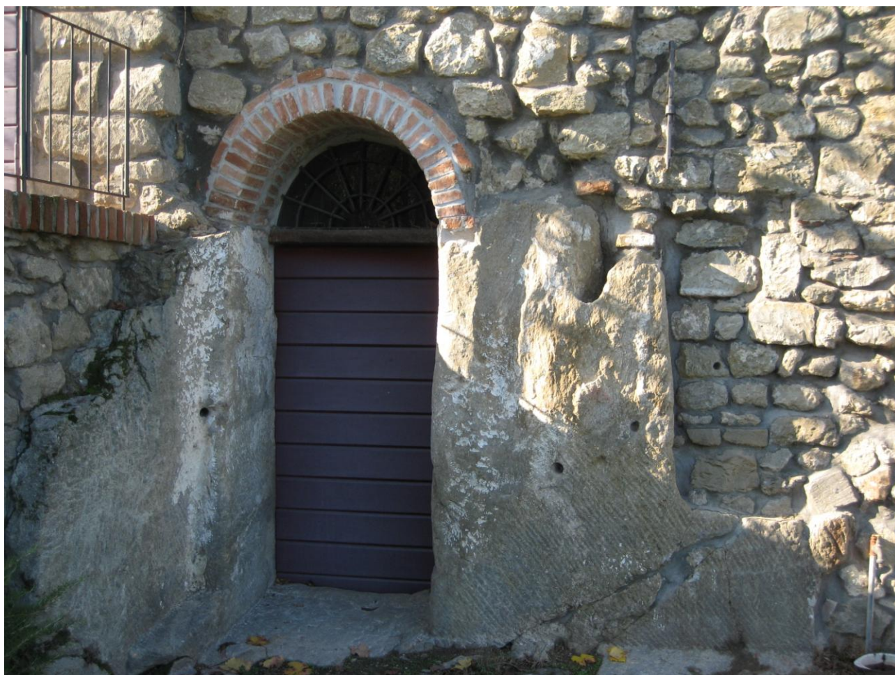
Fig. 74 – Ca' Marana: particolare del corpo di fabbrica inferiore, realizzato sagomando la roccia in posto (foto S. Piastra). Sono visibili i segni di lavorazione di un attrezzo metallico appuntito (scalpello? Gradina?).
