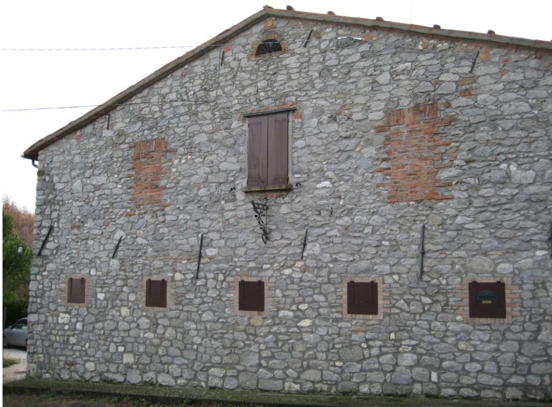
Fig. 8 – Ca’ Il Borgo di Rontana (tipo imolese-faentino): nella disposizione originale degli spazi, al piano terra è presente la stalla, individuabile grazie ai portelli metallici; al primo piano le camere da letto (foto S. Piastra). La scala di accesso è interna al fabbricato.
