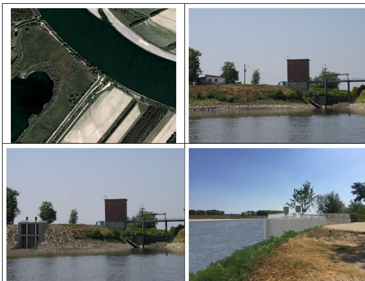
Figura 2 – Vista dell'opera di presa irrigua in corrispondenza della foce del torrente Ongina rispettivamente nello stato attuale (sopra) e con l'inserimento dell'opera in progetto (sotto; render)
