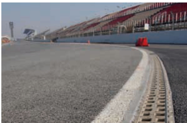
Figura-11: Il sistema Monoblock per il drenaggio della pista
