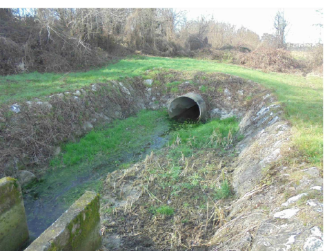
7 - VASCA DI DISSIPAZIONE E CANALETTA A CIELO APERTO DI VALLE
