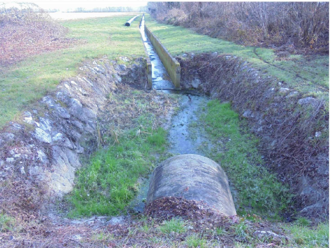
8 - ARGINE IN SPONDA SINISTRA DEL RIO CAMPANARA NEL TRATTO A FIANCO DELLA VASCA DI DISSIPAZIONE
