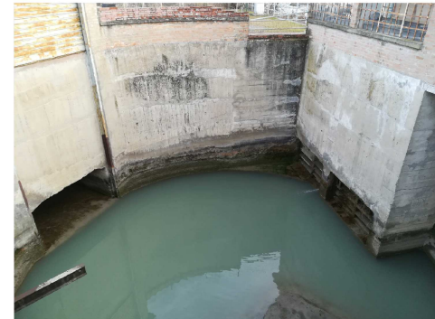
7 - VISTA INTERNA DELLA VASCA DI CALMA CON A SINISTRA LE PARATOIE DI REGOLAZIONE DELLE PORTATE DI INGRESSO E A DESTRA L'IMBOCCO DEL CANALE DEL DUCA
