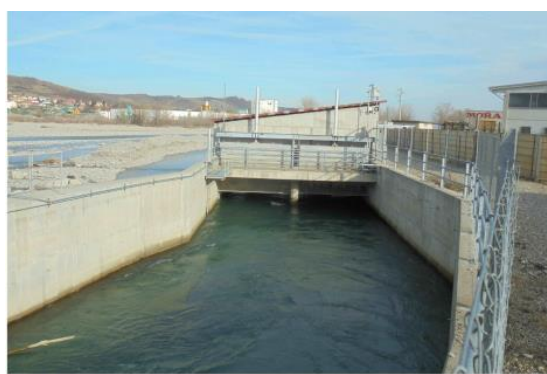
FIGURA 3-7: CANALE DI DERIVAZIONE DELLE PORTATE DELLA CENTRALE IDROELETTRICA IN DESTRA TARO (FOTO 11)
