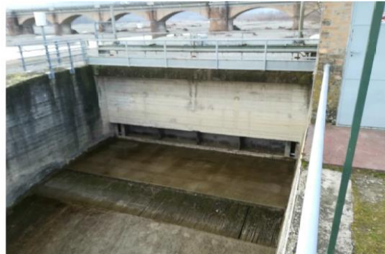
FIGURA 3-3: OPERA DI PRESA CON VISTA DELLA TRAVERSA MOBILE E DELLA GRIGLIA DI DERIVAZIONE DI FONDO
