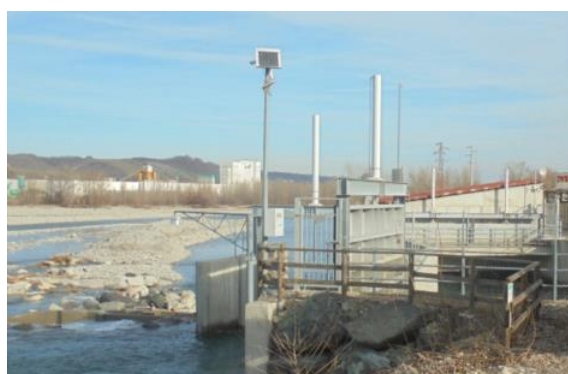
FIGURA 3-6: CENTRALINA IDROELETTRICA IN DESTRA TARO CON VISTA DELLA SCALA DI RISALITA DEI PESCI (FOTO 10)
