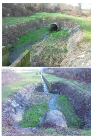
FIGURA 3-12: VASCA DI DISSIPAZIONE DELLA CORRENTE IN ARRIVO DALLA CONDotta DI MEDESANO E CANALETTA DIRETTA AL CANALAZZO
