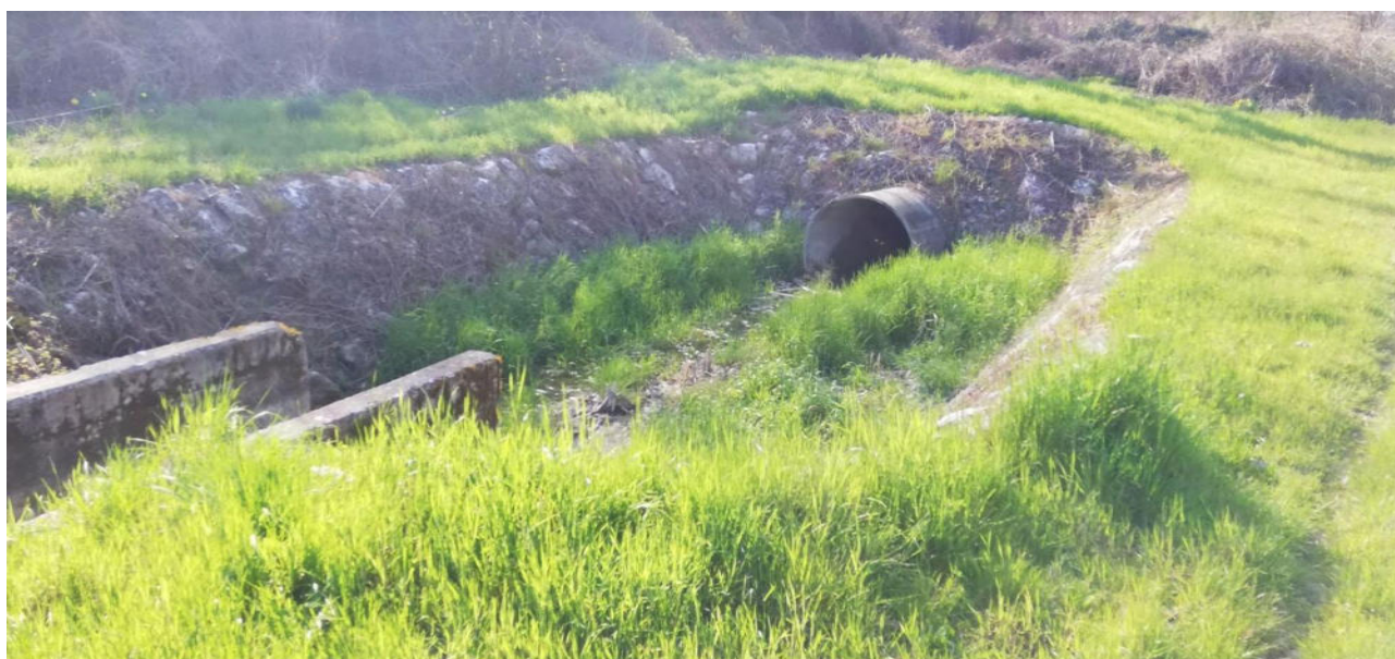
FOTO 2 – VASCA ALLO SBOCCO DELLA CONDOTTA INTERRATA ESISTENTE
