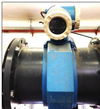
Figura 9 – Misuratore magnetico installato sulla linea di adduzione di laboratorio
