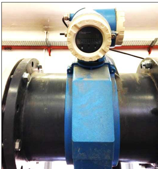
Figura 7 MISURATORE MAGNETICO INSTALLATO SULLA LINEA DI ADDUZIONE DI LABORATORIO
