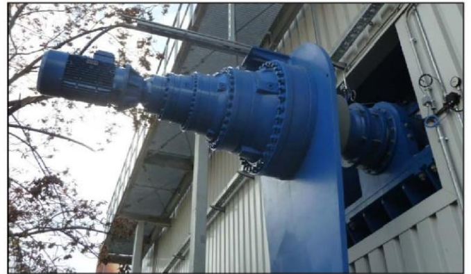
Fig.6.: Particolari degli organi di movimentazione interni del digestore, di tipo longitudinale (in alto) o trasversale (in basso), a seconda del costruttore
