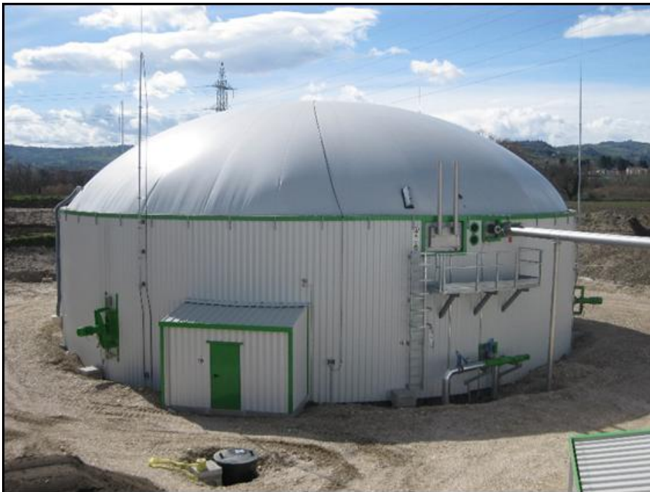
Fig.8.: Digestore secondario (immagine indicativa)
