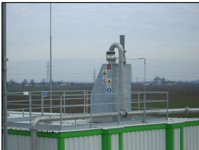
Fig.3.: Valvola di sicurezza sul tetto del digestore primario
