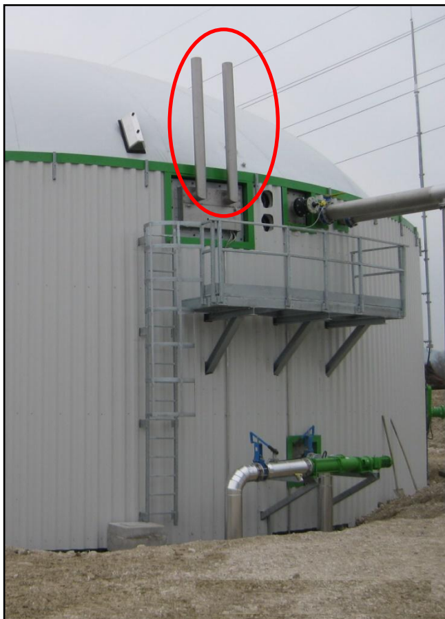
Fig.10.: Il cerchio rosso identifica i camini delle due valvole di sicurezza
