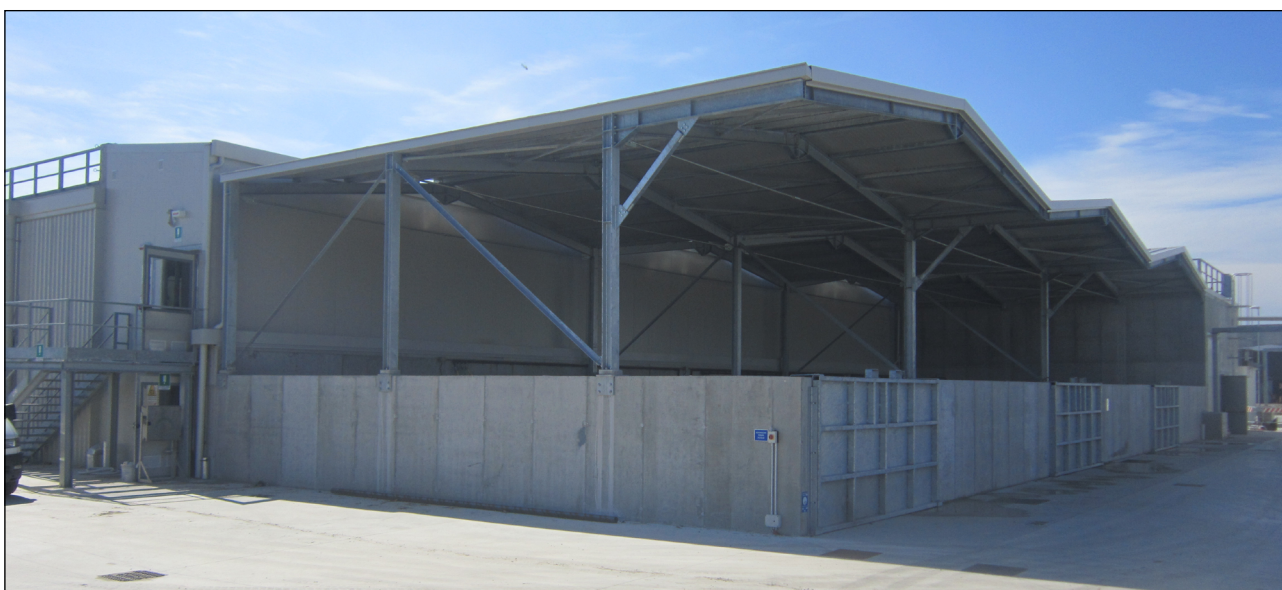
IMMAGINE 6 - Vista del biofiltro a servizio del Capannone di digestione anaerobica esistente
