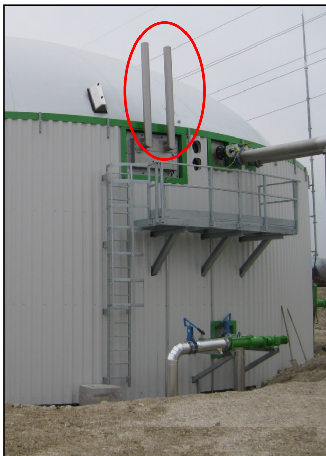
Fig.22.: Il cerchio rosso identifica i camini delle due valvole di sicurezza
