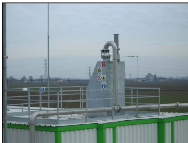
Fig.15.: Valvola di sicurezza sul tetto del fermentatore primario
