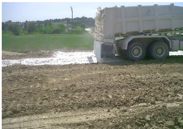
Figura 5.2- Esempio di stesa di UNIROAD SPTM
