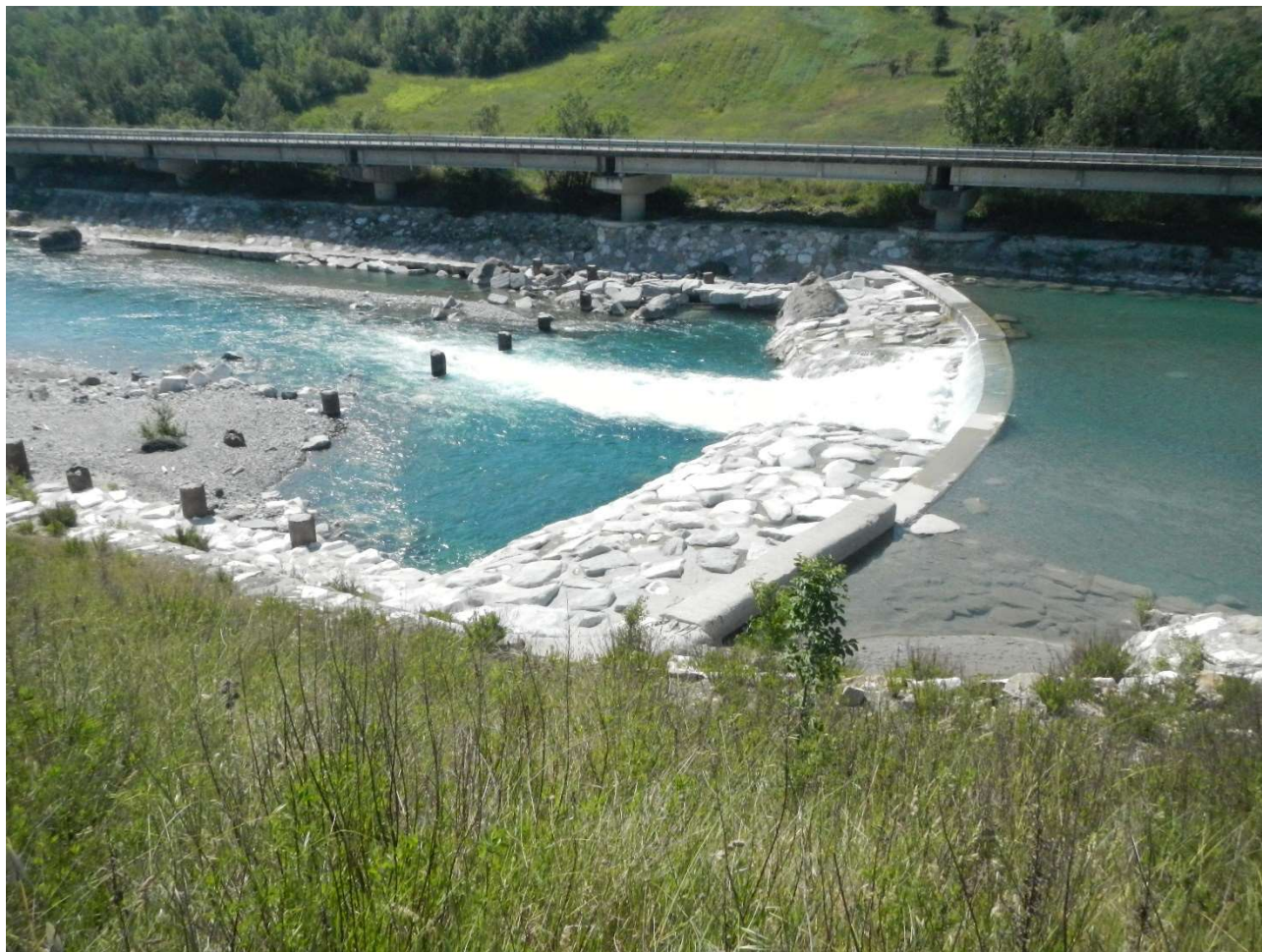
Figura 9 – Aspetto della briglia in condizioni di magra: si noti il passaggio della vena liquida solo dalla gaveta centrale. Da questa immagine si può notare la presenza di una platea in massi anche a monte della briglia (in sinistra), il pennello antiersivo (estrema dx nell'immagine), la scogliera continua e le strutture della SS45.
