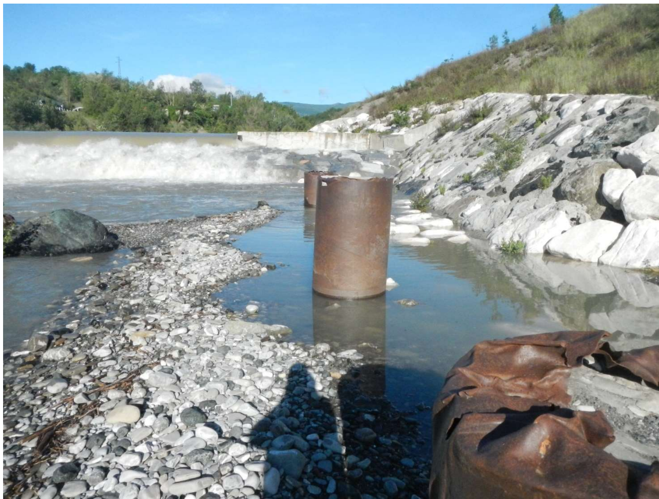
Figura 21 – Foto della briglia (ala sinistra) ripresa da valle. Si nota la presenza della briglia in ca (la gaveta è sommersa), delle imponenti scogliere e platee, e dei pali di grande diametro. Si riesce a notare anche la composizione media granulometrica del materiale d'alveo, compreso (estrema sx nell'immagine) la presenza di un blocco ofiolitico.
