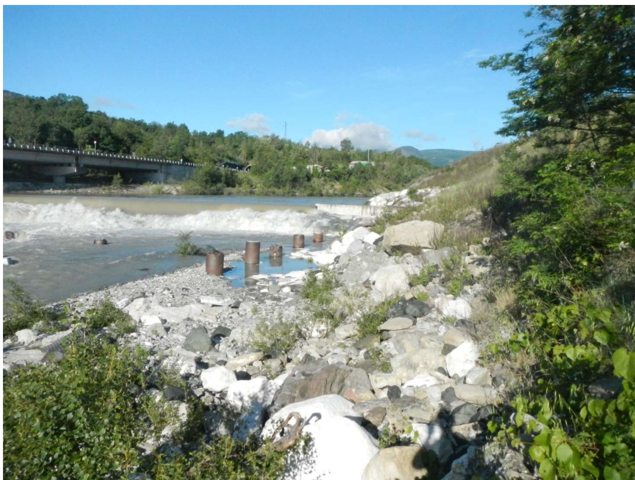
Figura 19 – Aspetto della sponda fluviale sinistra con visibile, sullo sfondo, la briglia in condizioni di portata medio-elevate. Sulla sponda si nota la presenza dei massi alla rinfusa e di scogliere a secco; al piede, la presenza di pali di grande diametro (diametro 1 m) quali opere di rinforzo della struttura. L'alveo è ricoperto da ghiaie. La briglia, in ca, è parzialmente ricoperta dalla vena idrica stramazzante (il momento in cui è stata scattata la foto la portata registrata a Bobbio era di ca. 49 mc/s).
