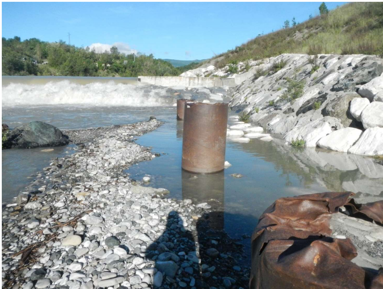
Figura 8 – Foto della briglia (ala sinistra) ripresa da valle. Si nota la presenza della briglia in ca (la gaveta è sommersa), delle imponenti scogliere e platee, e dei pali di grande diametro. Si riesce a notare anche la composizione media granulometrica del materiale d'alveo, compreso (estrema sx nell'immagine) la presenza di un blocco ofiolitico.
