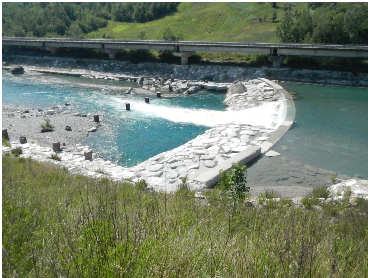
Figura 22 – Aspetto della briglia in condizioni di magra: si noti il passaggio della vena liquida solo dalla gaveta centrale. Da questa immagine si può notare la presenza di una platea in massi anche a monte della briglia (in sinistra), il pennello antiersivo (estrema dx nell'immagine), la scogliera continua e le strutture della SS45.
