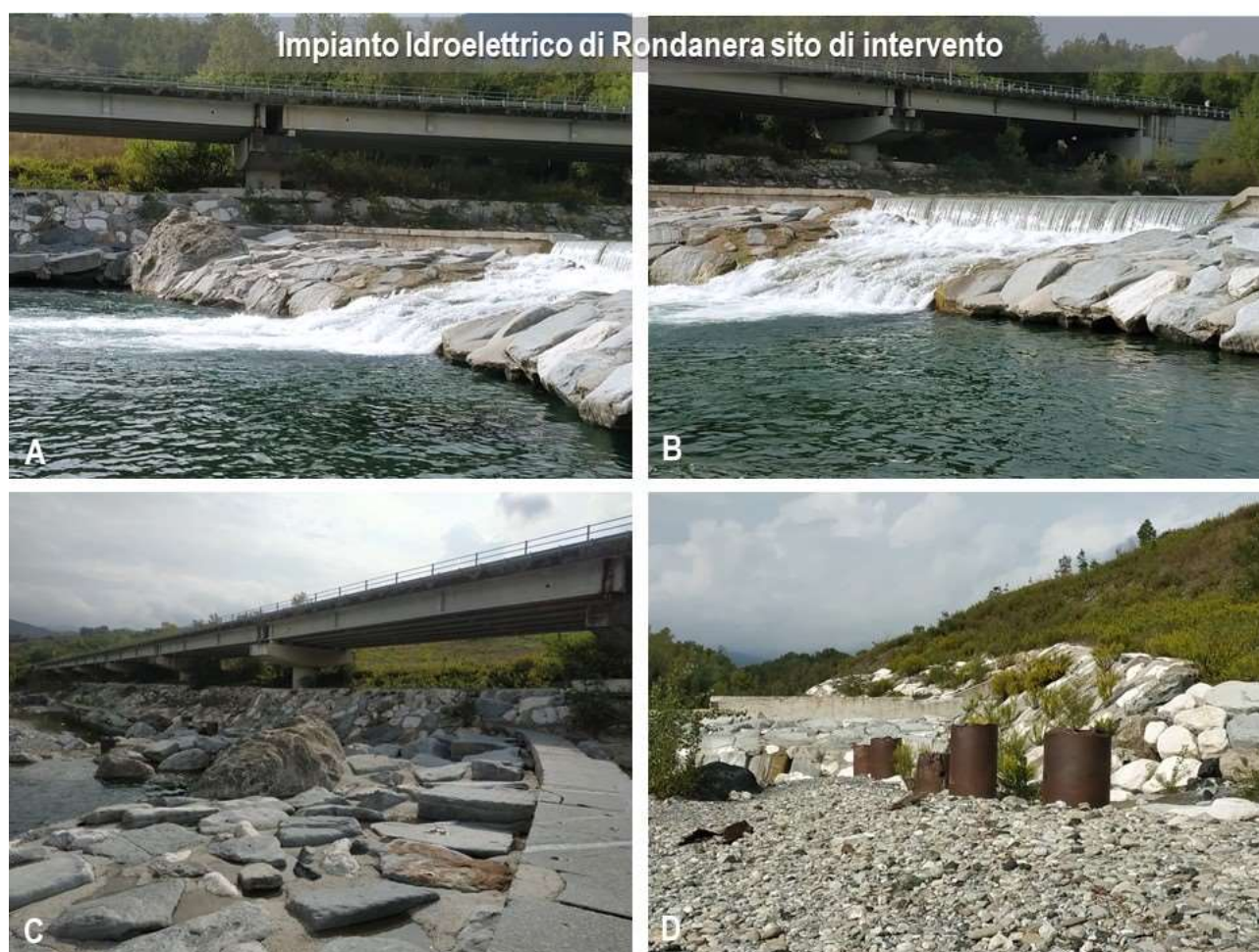
Figura 11: immagini relative alla sponda idrografica destra. In A lato destro della traversa (realizzata con massi intasati) e la sponda fluviale completamente artificializzata sovrastata dalla SS 45. IN B: vista della porzione centrale della gaveta, sulla quale verrà inserita la struttura di regimazione. In C dettaglio della traversa che presenta al piede una platea di massi intasati a consolidarne la base. In D dettaglio del lato sinistro della traversa con presenza dei resti di piloni metallici.
