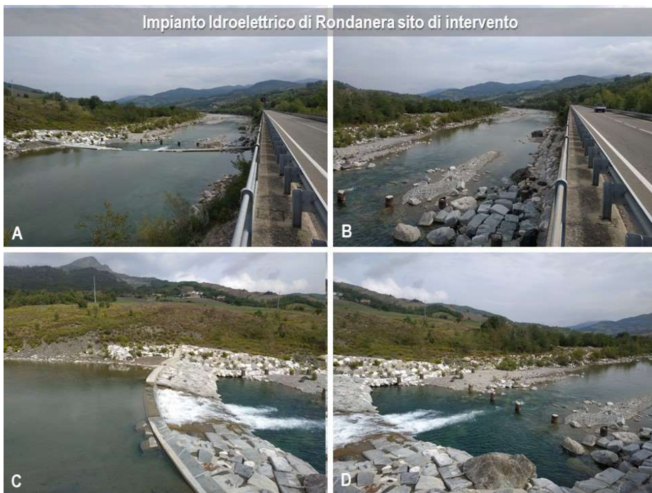
Figura 12: viste della sponda idrografica sinistra in corrispondenza del tratto di inserimento dell'impianto. In A panoramica del tratto di inserimento delle opere, il canale di adduzione si aprirà accanto alla traversa esistente; in B tratto di sponda immediatamente a valle del punto in cui verranno restituite le acque. In C la spalla della traversa esistente dove verrà realizzato il corpo centrale dell'impianto. In D, porzione in cui si svilupperà la porzione finale del canale di restituzione.
