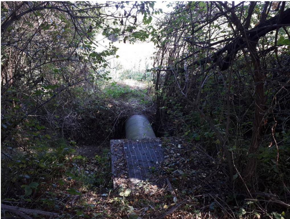
Figura 4-4. Tubazione di bypass per il superamento del canale irriguo (Ø 800 mm).
