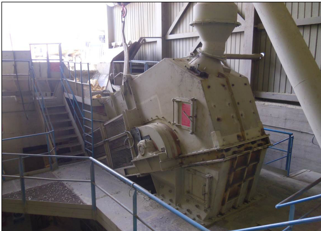
Foto 4.6: La frantumazione avviene nel frantoio a martelli posto a valle della tramoggia, esso è il punto nevralgico meccanico dell'intero impianto.
