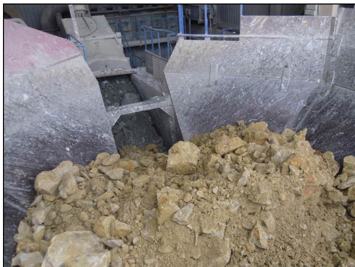
Foto 4.4: Il disintasamento della tramoggia di alimentazione è una delle problematiche ordinarie più ricorrenti, ciò in quanto non è sufficiente il solo controllo visivo di ciò che giunge in entrata. Infatti, soprattutto in inverno col materiale umido, la produzione oraria rallenta considerevolmente per dare il tempo alla marna “impaccata” di scendere lungo il cono.
