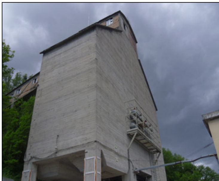
Foto 4.2: Il silos e la tramoggia di scarico del frantoio.
