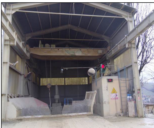
Foto 4.5: In presenza di blocchi di dimensioni tali da non poter essere frantumati ( diam > 70\text{ cm} ), si ricorre al carroponte per prelevarli ed estrarli fisicamente dalla tramoggia.
