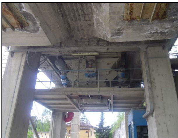
Foto 4.9: La tramoggia di scarico è il punto di arrivo della marna frantumata; da essa confluisce per gravità sul cassone dei mezzi adibiti al trasporto verso la cemeniera di Vernasca.
