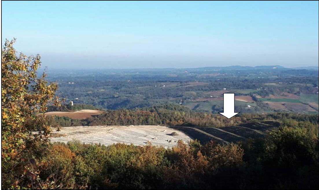
Figura 2-8 - Il cantiere di Canova con la porzione gradonata di sinistra già oggetto dei definitivi interventi di ricomposizione forestale (freccia bianca).
