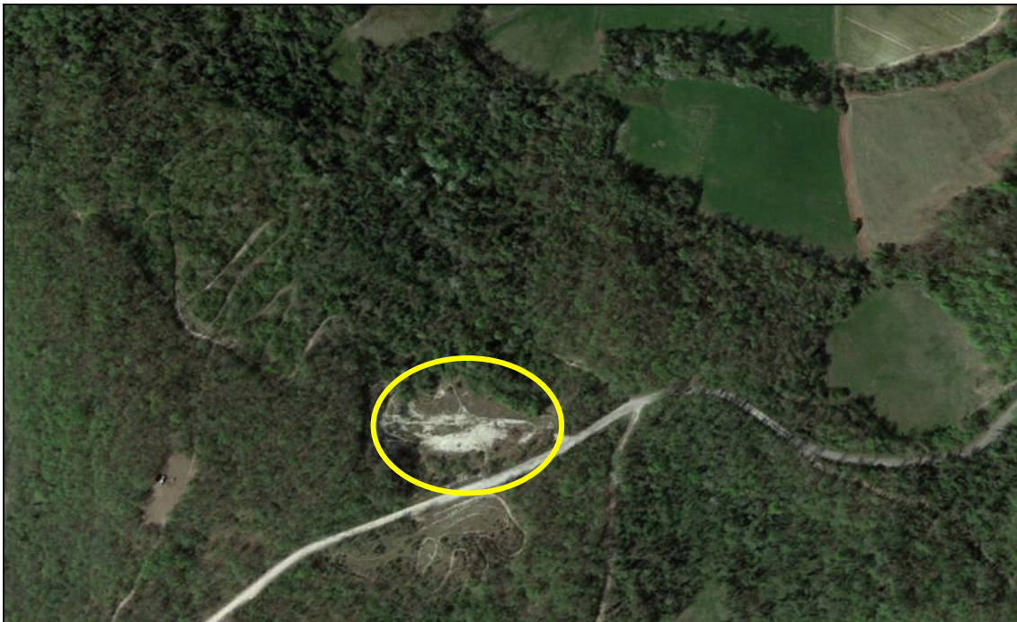
Figura 2-7 - Il sito di Costa di Breno allo stato attuale individuato dal contorno giallo.
