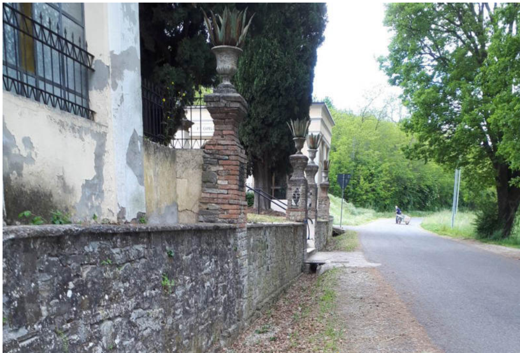
Figura 4-7. Si noti il tubo di 250 mm in corrispondenza dell'ingresso del cimitero
