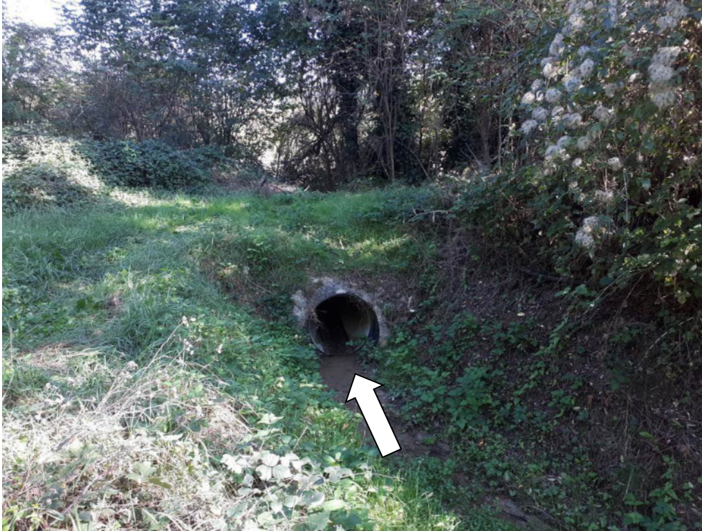
Figura 4-3. Ingresso della tubazione di bypass per il superamento del canale irriguo. La freccia indica la direzione dell'acqua.
