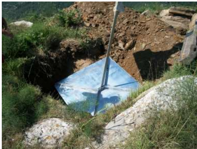
Figura 2.2 – Modalità di ancoraggio tramite piastre interrate.
