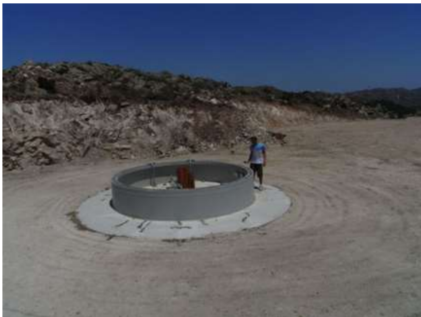
Figura 5.11: Fondazione di un aerogeneratore Vestas V90 in configurazione definitiva
