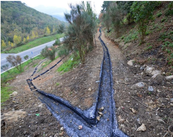
FIGURA 4: ESEMPIO DI CANALETTE PER IL DRENAGGIO SUPERFICIALE ESEGUITI MEDIANTE ASPORTAZIONE DEL TERRENO PER LA CREAZIONE DEL CANALE DI SCOLO E POSA SUCCESSIVA CON ELEMENTI IN CLS PREFABBRICATO.
