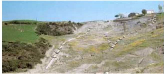
FIGURA 4: ESEMPIO DI CANALETTE PER IL DRENAGGIO SUPERFICIALE ESEGUITI MEDIANTE ASPORTAZIONE DEL TERRENO PER LA CREAZIONE DEL CANALE DI SCOLO E POSA SUCCESSIVA CON ELEMENTI IN CLS PREFABBRICATO.
