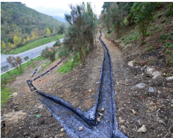
Figura 5.9: esempio di canalette per il drenaggio superficiale eseguiti mediante asportazione del terreno per la creazione del canale di scolo e posa successiva con elementi in cls prefabbricato.
