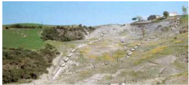
Figura 5.9: esempio di canalette per il drenaggio superficiale eseguiti mediante asportazione del terreno per la creazione del canale di scolo e posa successiva con elementi in cls prefabbricato.
