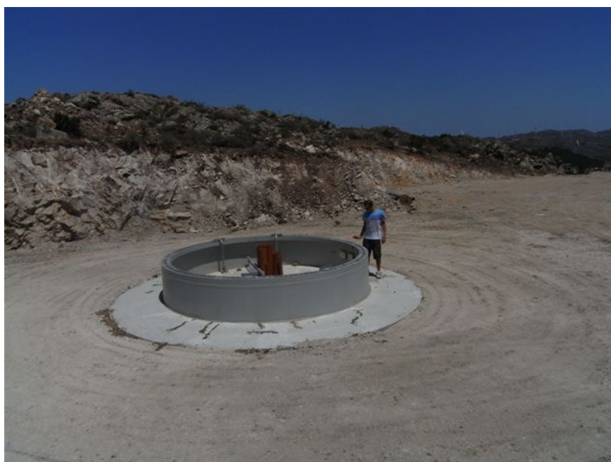
Figura 5.11 - Piazzola di un aerogeneratore Enercon E82 in configurazione definitiva.
