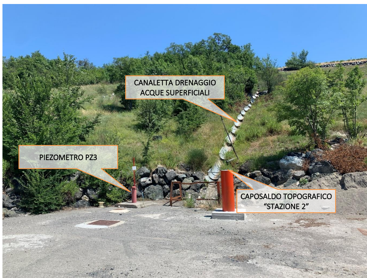
Figura 3.16: FOTO 07 - Vista del piazzale di ubicazione del Piezometro PZ3 e- Particolare delle canalette di drenaggio delle acque meteoriche
