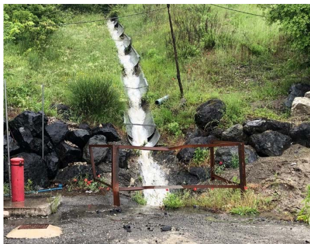
Figura 3.2: Canalette in acciaio ondulato con salto - acque dal settore est dell'impianto
