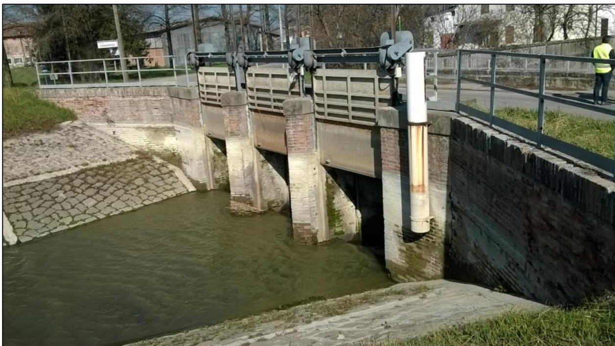
Foto n.8 – Cavo Bondeno – manufatto di barricazione per presa irrigua Condotta Pennella
