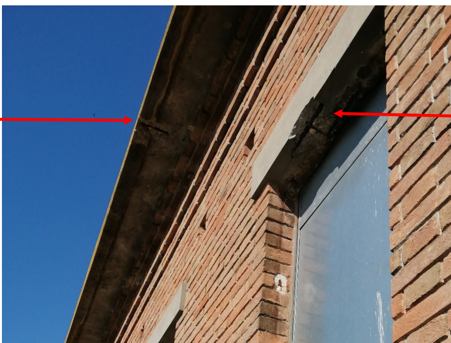
Particolare: degrado elementi in cemento armato
