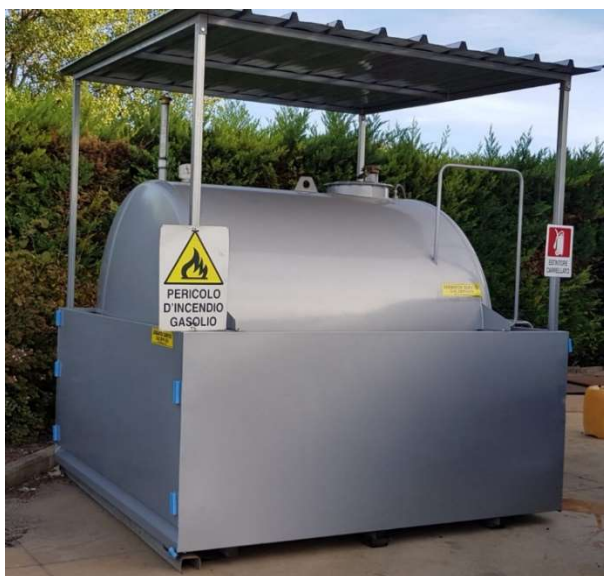
Figura 34 – Esempio di skid per stoccaggio e rifornimento gasolio e di container per stoccaggio sostanze pericolose
