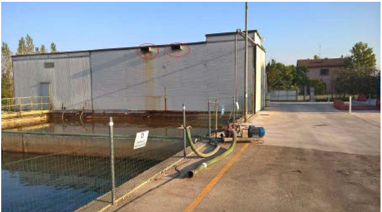
Figura 14 Il fabbricato dell'impianto Osmosi. Gli scarichi aria di raffreddamento sono evidenziati con il cerchio rosso. Sullo sfondo si vede R1.
