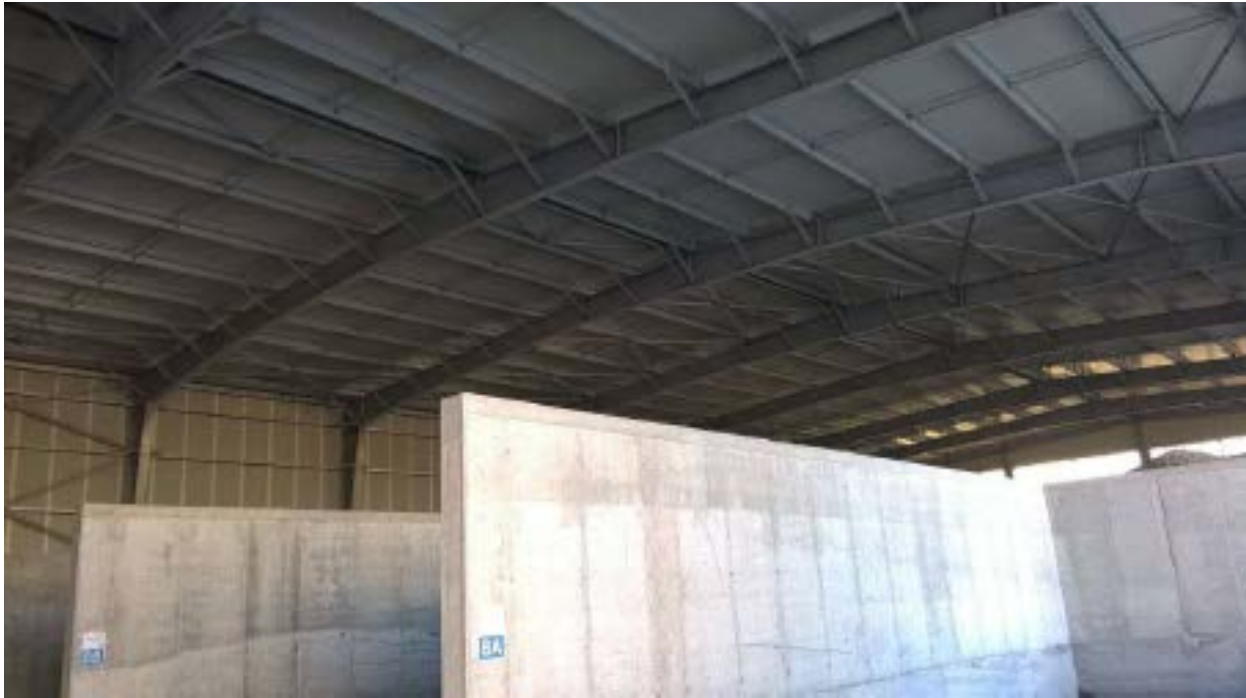
Figura 7 La sorgente S5 (fabbricato baie stoccaggio inerti) visto dall'interno. Notare sul fondo la parete di tamponamento lato est costituita pannelli sandwich fonoisolanti e fonoassorbenti, microforati sul lato interno.
