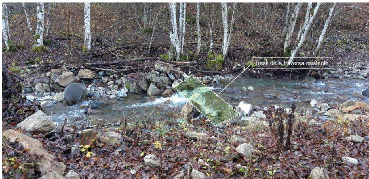
Figura 24: vista del tratto in cui verranno inserite le strutture di captazione. La presa verrà realizzata in corrispondenza di una struttura preesistente di regimazione.
