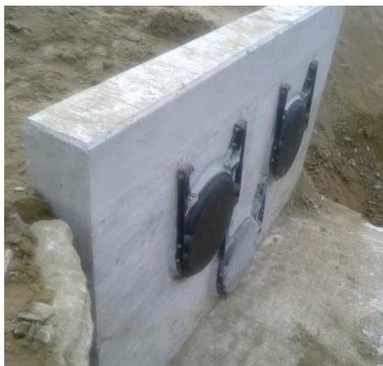
Foto 13 - Tipologia di scarichi di fondo a clapet (fiume Ronco cassa di espansione vasche SFIR)
