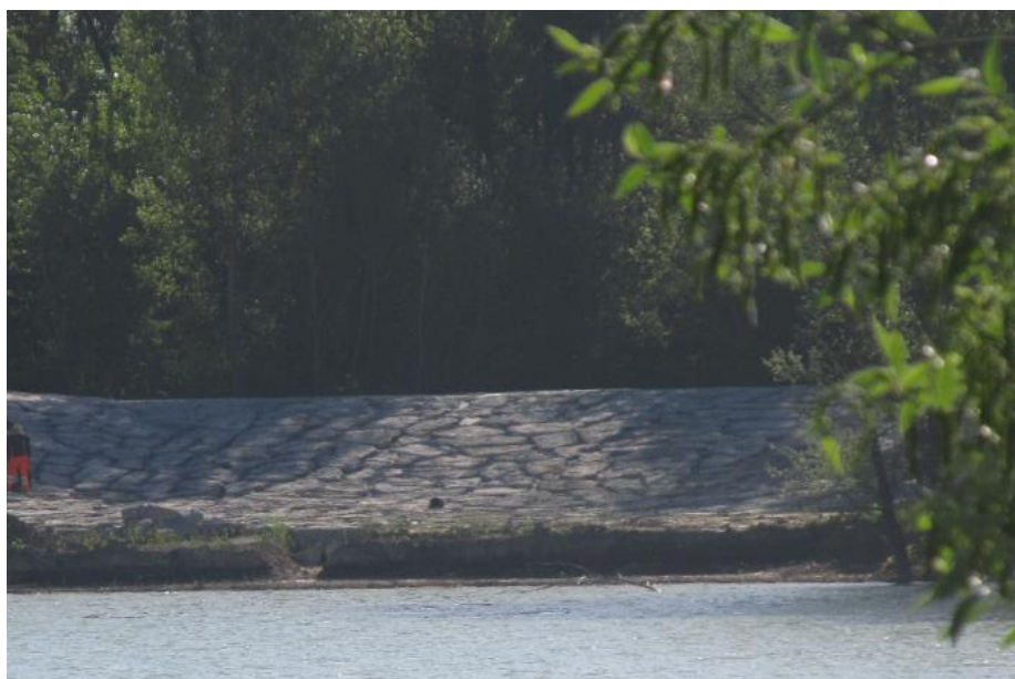
Foto 11- Tipologia di argini rinforzati in massi per sfiori laterali (fiume Ronco a Magliano- Forlì)
