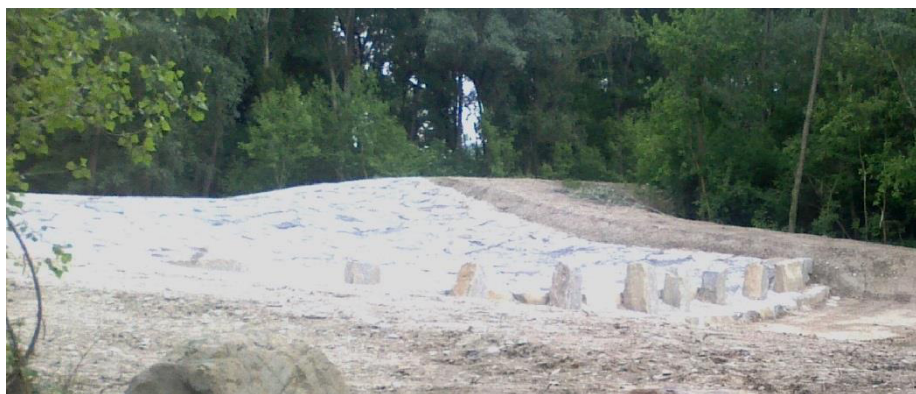
Foto 12- Tipologia di sfioratori in massi (fiume Ronco a Magliano- Forlì)
