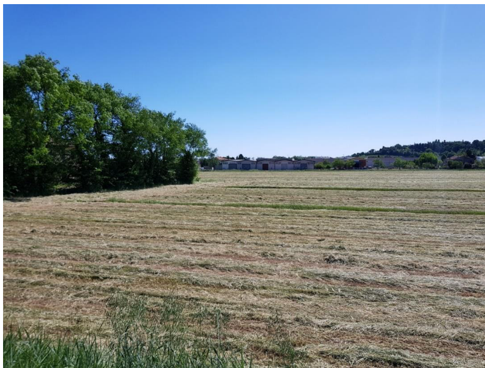
Foto n. 8 - Vista dell'area destinata a cassa di laminazione (direzione Nord - Est). La quota del fondo verrà leggermente ridotta. Le aree urbanizzate (partendo dal limite dell'area boscata visibile) saranno protette da una duna in terreno.
