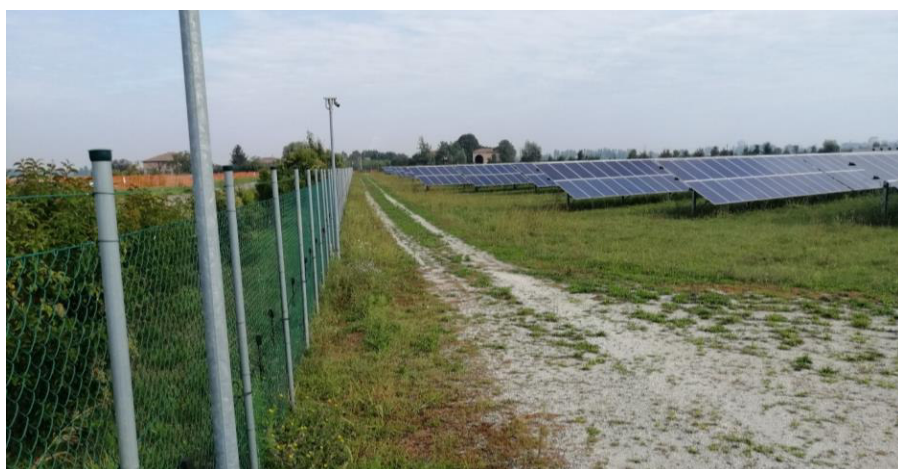
Foto 3.4.1 – Esempio di realizzazione di un impianto fotovoltaico senza fondazioni in cls, nel rispetto della risorsa “suolo”.
