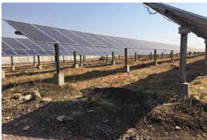
Figura 2.1.4 – Esempio di impianto fotovoltaico con fondazioni ottenute mediante perforazione del terreno e successiva creazione del palo di fondazione con getto di cemento.
