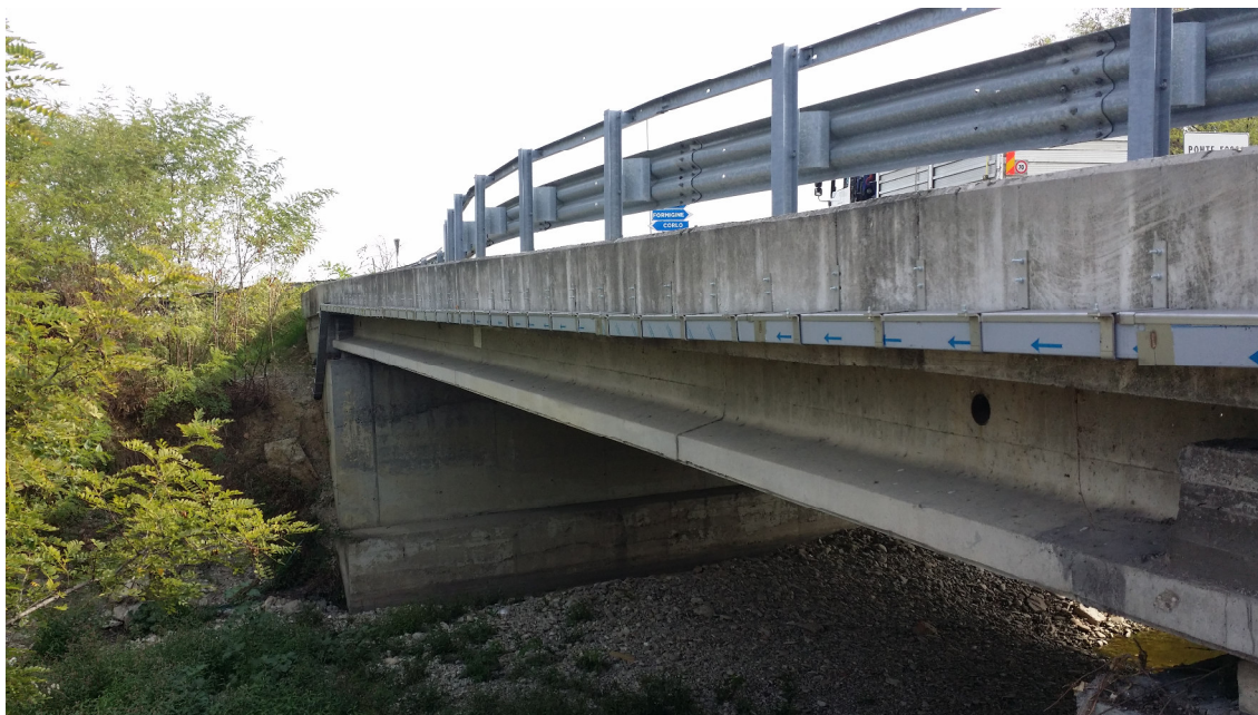
Figura 5.1.9 – Esempio tipologico di canalina staffata presso la struttura di un viadotto stradale.
