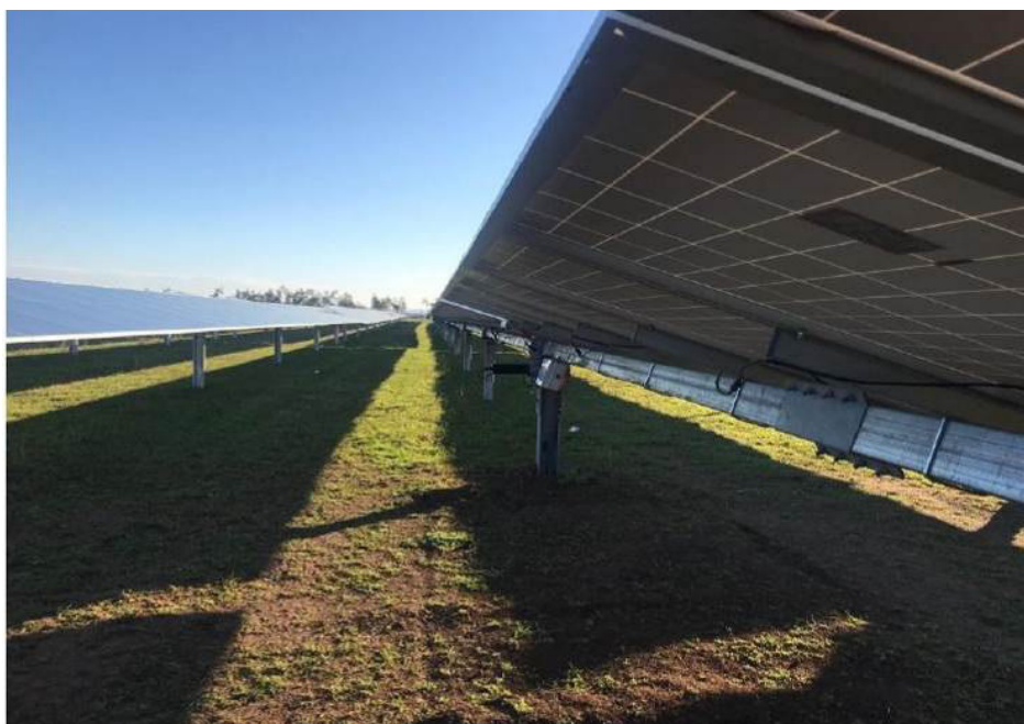
Figura 5.1.2 – Esempio di impianto fotovoltaico realizzato con supporti costituiti da pali in acciaio infissi direttamente nel terreno. Gli impatti sul suolo sottostante risultano essere minimizzati.
