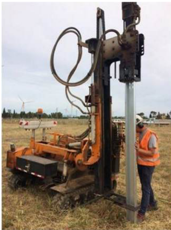
Figura 5.1.1 – Esempio di supporto costituito da palo in acciaio infisso direttamente nel terreno mediante battipalo.
