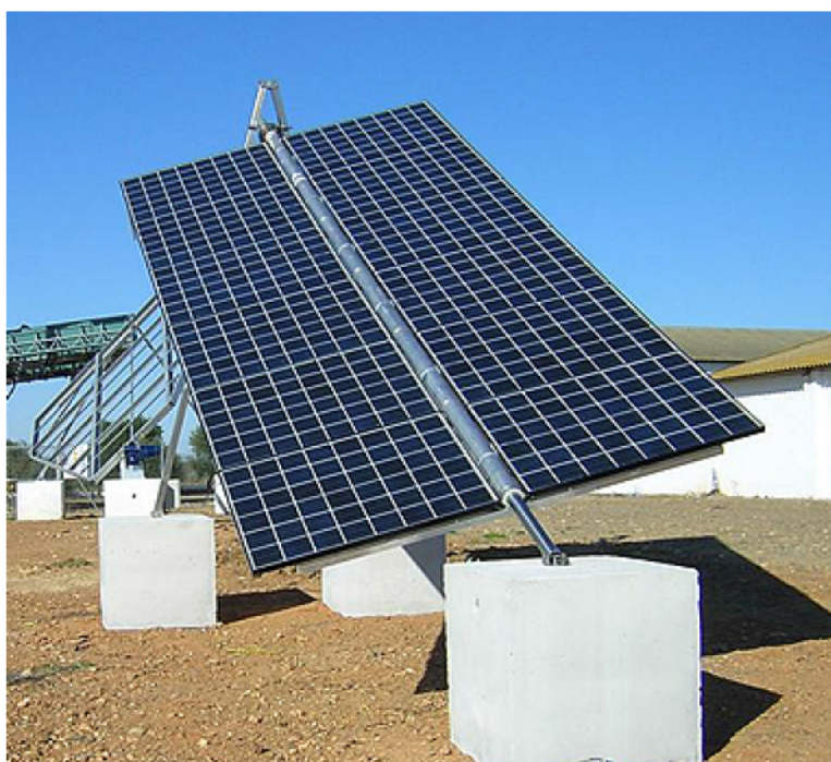
Figura 11: inseguitore ad asse polare
