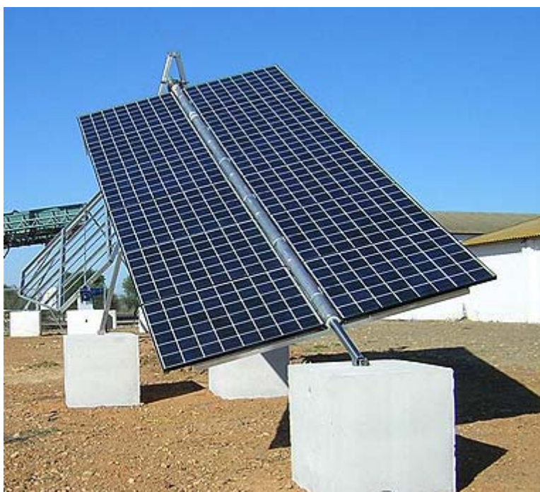
Figura 11: inseguitore ad asse polare
