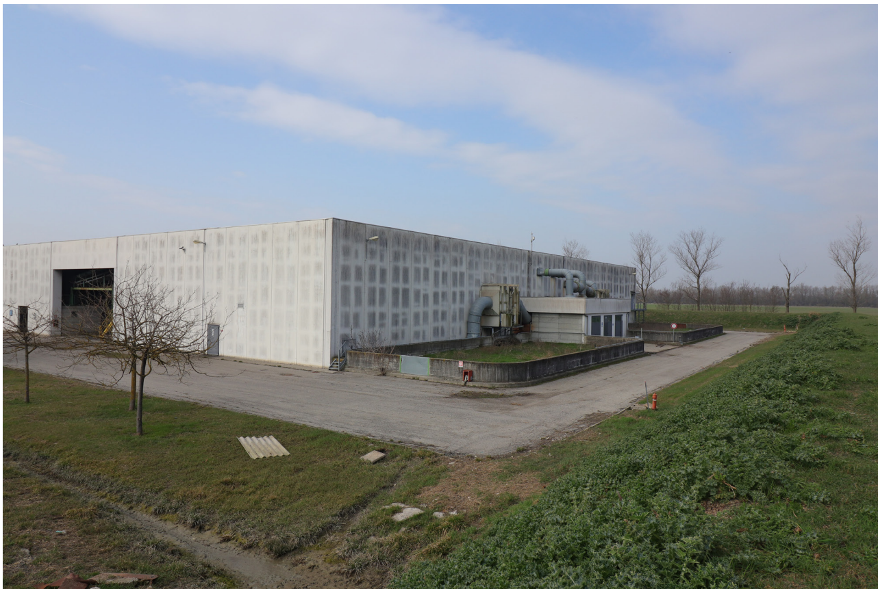
IMMAGINE 8 - Vista lato nord-ovest della zona destinata al trattamento delle arie esauste: biofiltri e locale ventilatori
