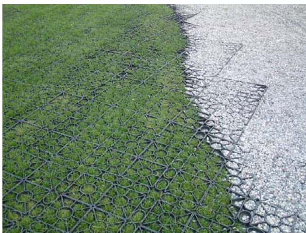
Fig.52.: Tipologico pavimentazioni in green realizzata con grigliati erbosi
