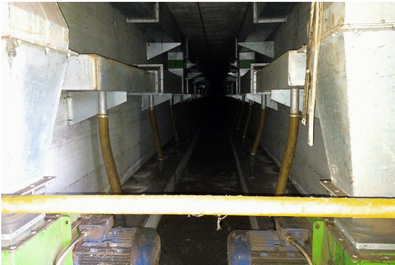
IMMAGINE 8 - Vista del corridoio tecnico (locale ventilatori) posizionato tra i due bacini di bioossidazione
