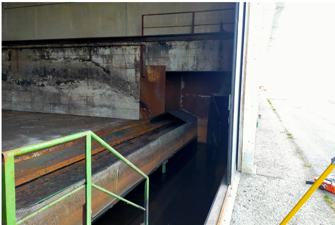
IMMAGINE 10 - Vista del sistema di scarico tra il bacino di biossificazione e la fossa contenente il nastro di trasporto del materiale diretto a maturazione
