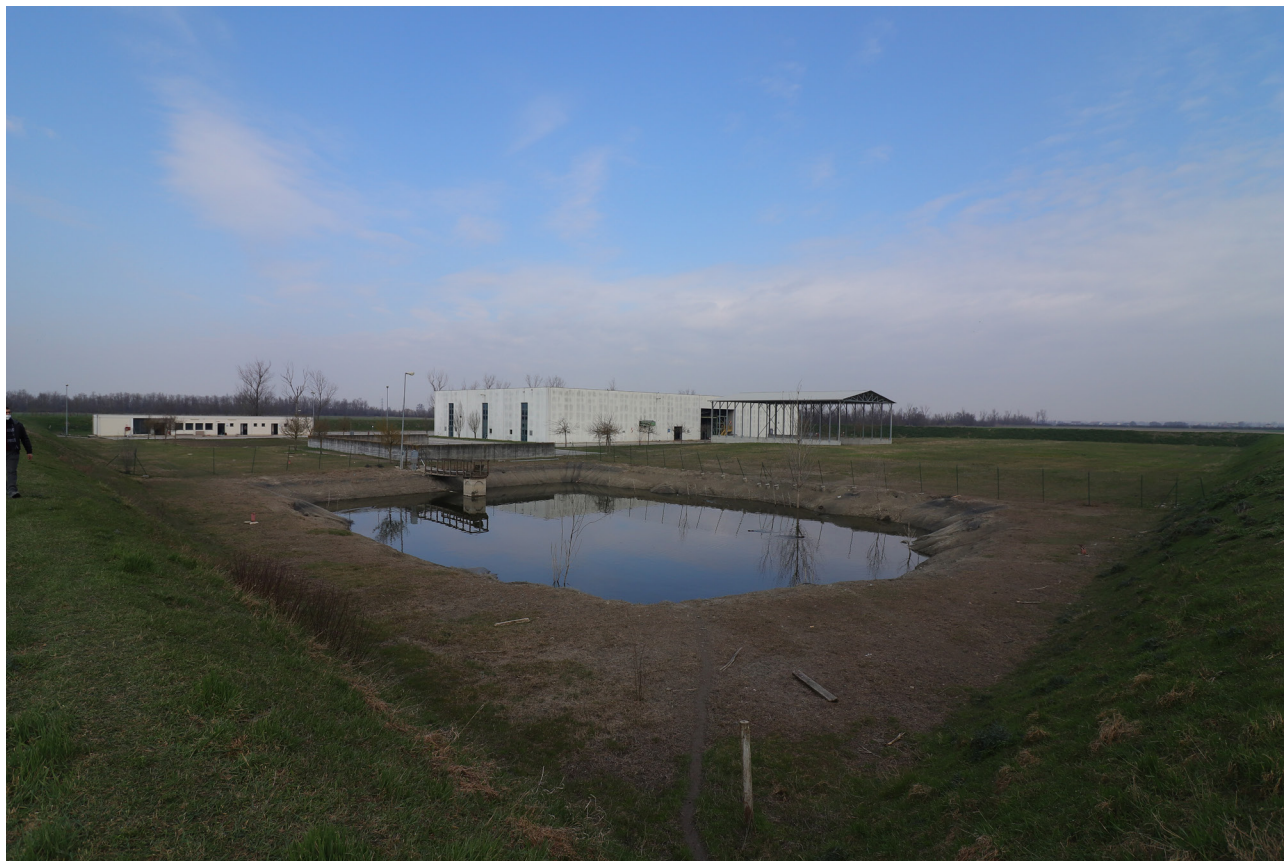
IMMAGINE 6 - Vista, dall'arginatura di protezione, della vasca di laminazione realizzata in terra
