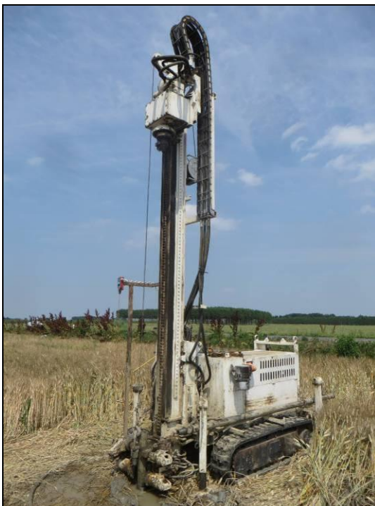
Figura 62. Area A. Il carotaggio in corso.
