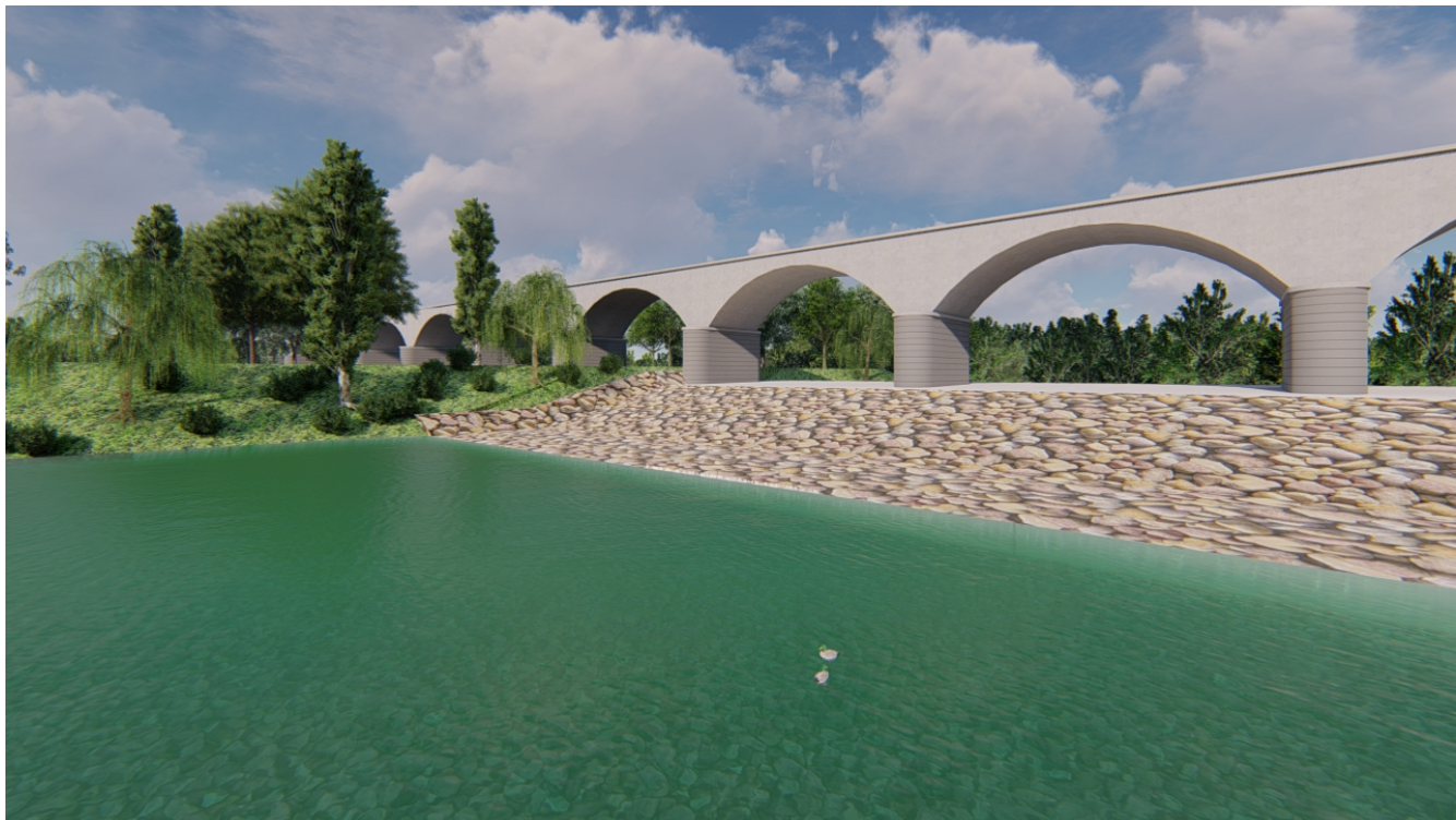
Render dell’opera in regime di magra con evidenziazione del rivestimento in alveo in massi lapidei (RipRap)
