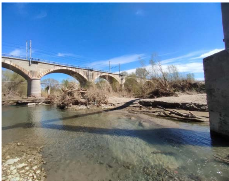
Figura 19 Alveo inciso e sponda destra a monte del ponte di Cintura, la prima pila a sinistra è la numero 10 oggetto di erosione nell'alveo inciso.
