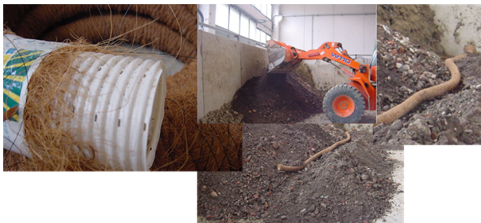
Figura 5.2 – Fasi di preparazione di una biopila
