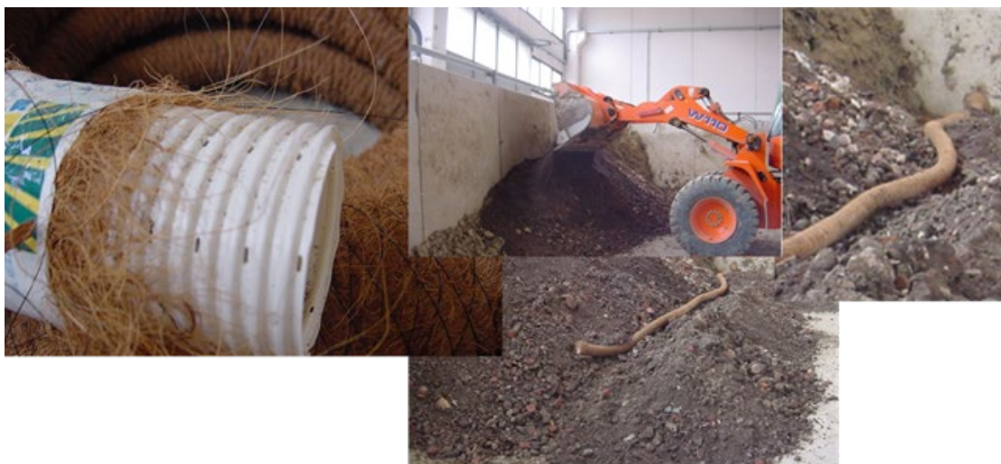
Figura 50 - Fasi di preparazione di una biopila
