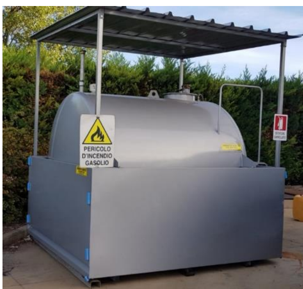
Figura 106 – Esempio di skid per stoccaggio e rifornimento gasolio e di container per stoccaggio sostanze pericolose
