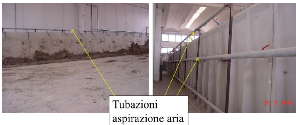
Figura 51 – Immagini di una baia di trattamento mediante bioremediation
